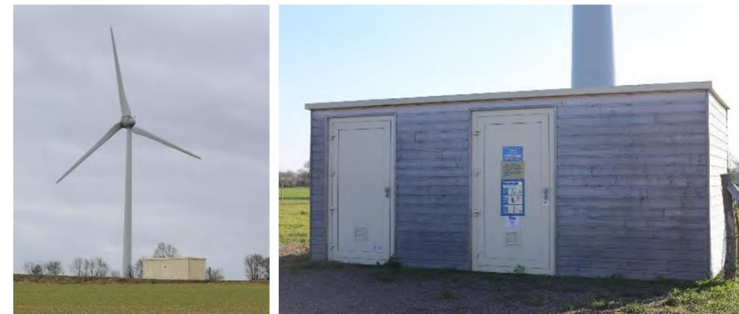
Figure 29 : Exemples de poste de livraison électrique
