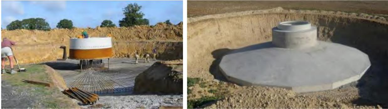
Figure 27 : Le ferrailage et le coulage d'une fondation d'éolienne
