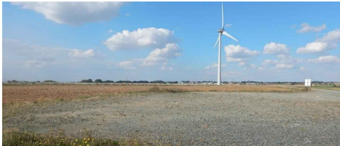
Photo 100 : Exemple d'aire de grutage depuis le pied d'une éolienne
