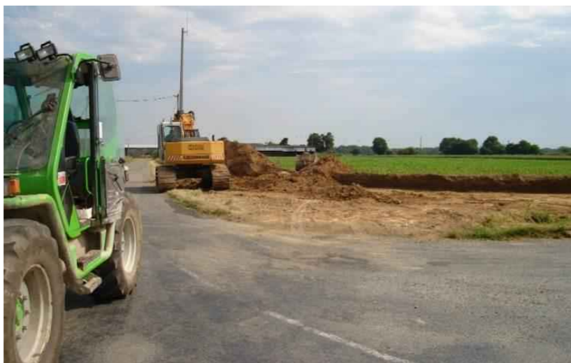
Photo 107 : Les travaux de rectification d'un virage
