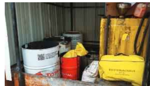
Exemple d'une aire de stockage des matériaux polluants dans un conteneur étanche associé à un kit anti-pollution. Certains produits sont isolés du sol et disposés sur des bacs de rétention ou géotextile absorbant © AFB
