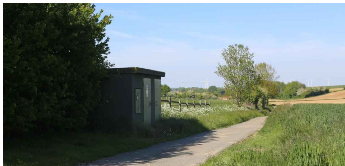
Figure 140 : Exemple de poste de livraison suggéré
