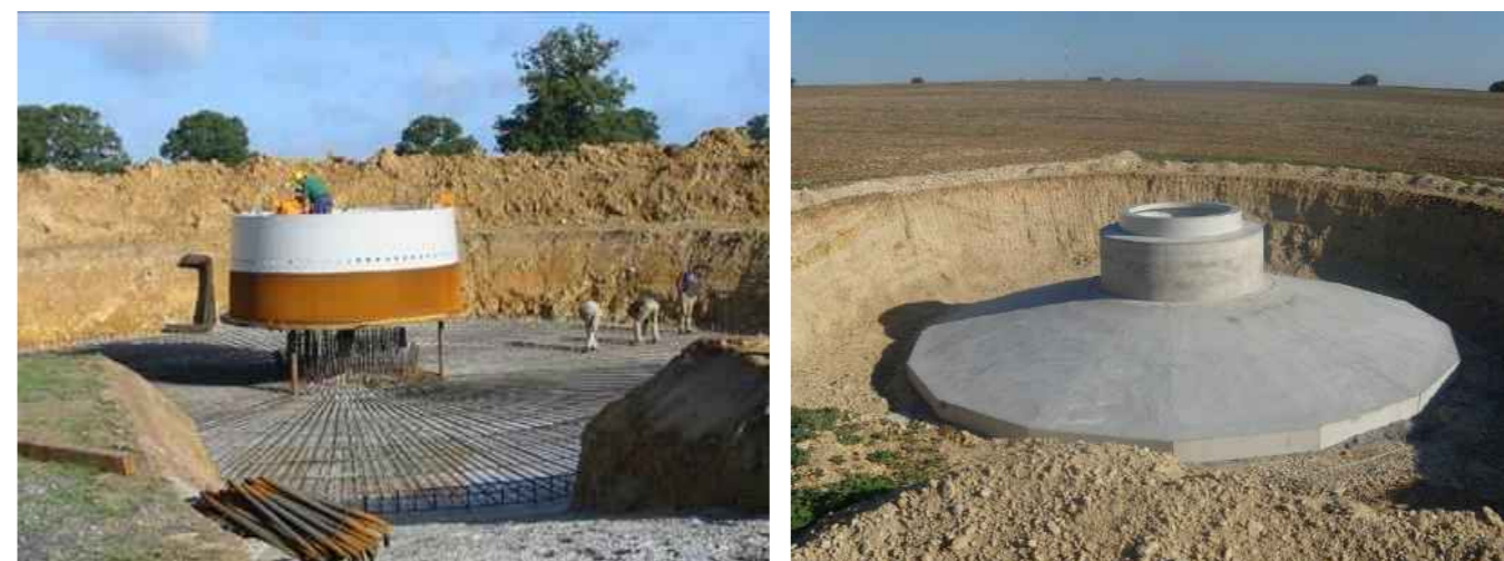
Photo 99 : Le coulage d'une fondation d'éolienne
