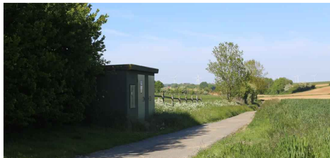
Figure 144 : Exemple de poste de livraison suggéré
