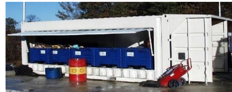
Tri sélectif des déchets de chantier (source : Biotope)
