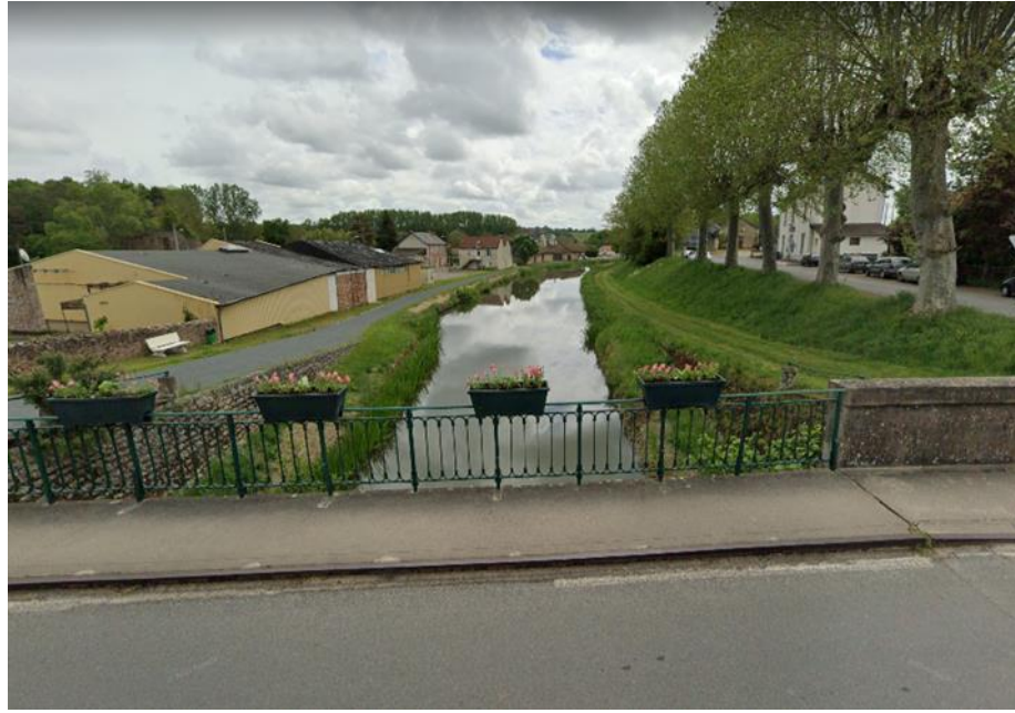
Figure 65 : Vue sur le pont du Canal de Berry (source : Google Street View, 2021)
