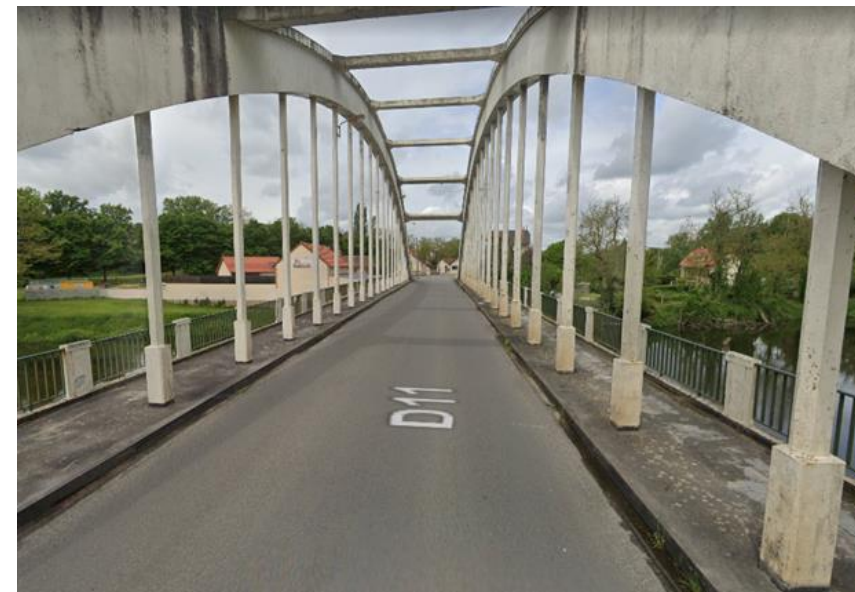
Figure 64 : Vue sur le pont du Cher à Vallon-en-Sully (source : Google Street View, 2021)
