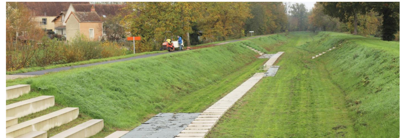
Photo 57 : Les aménagements du Canal de Berry déclassé à Ainay-le-Vieil
