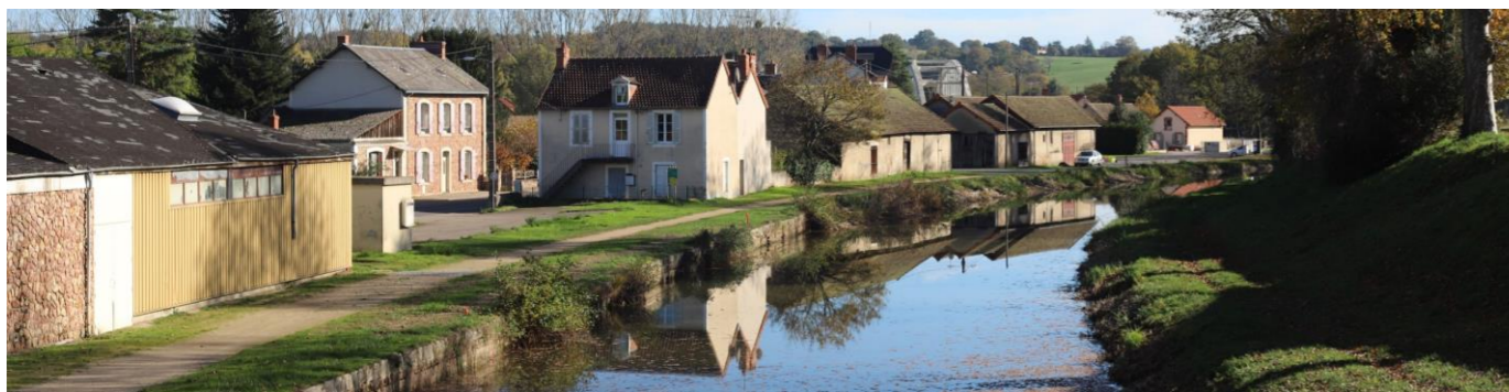
Photo 10 : Le Canal de Berry dans la vallée du Cher à Vallon-en-Sully – une structure patrimoniale incontournable
