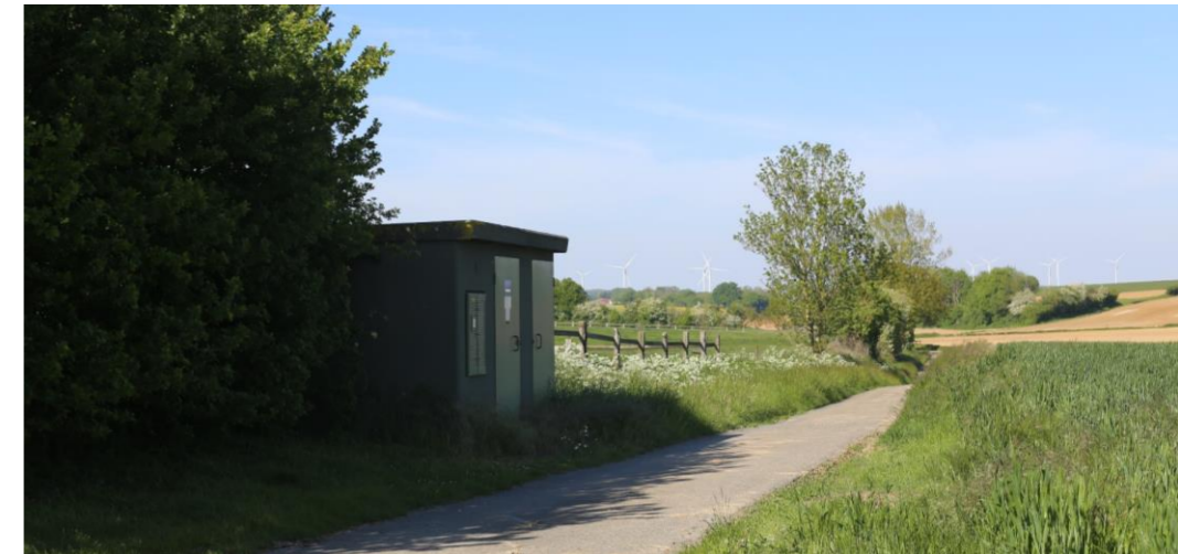
Figure 35 : Exemple de poste de livraison suggéré
