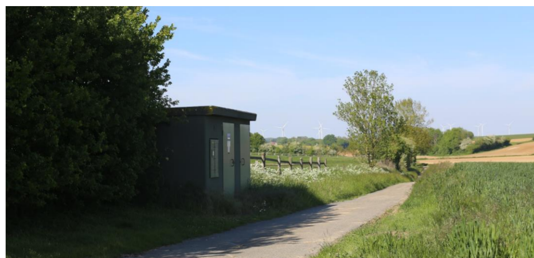
Figure 38 : Exemple de poste de livraison suggéré
