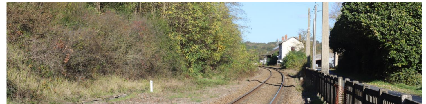
Photo 45 : La voie ferrée se situe dans un point bas et est bordée par une trame végétale dense
