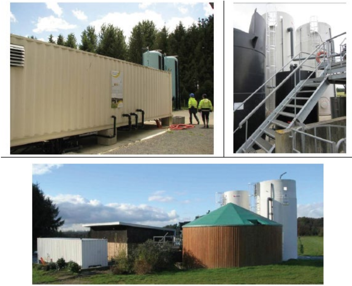
Figure 104 : Photos de la station d'épuration
