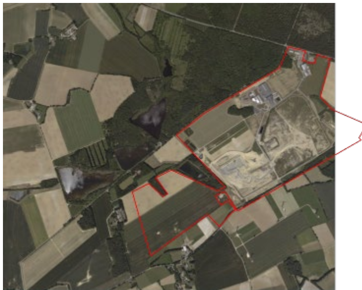
Figure 24 : Vue aérienne du site actuel en 2011 (Source : IGN « Rubrique Remonter le Temps »)
