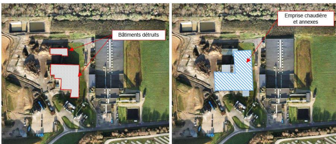
Agencement actuel de la plateforme de valorisation et localisation de l'emprise de la future chaudière HPCI et ses annexes
