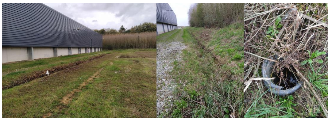
Fossé situé au sud de la parcelle (Gauche) ; Fossé située au Sud-Ouest de la parcelle et buse d'évacuation des eaux (Centre et Droite)
