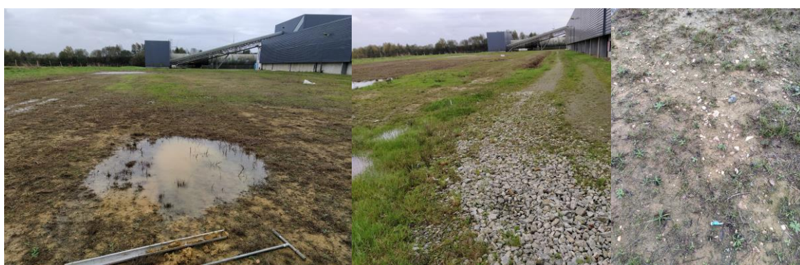
Dépressions remplies d'eau dans la zone décaissée (gauche) et remblai dans cette même zone (centre et droite)
