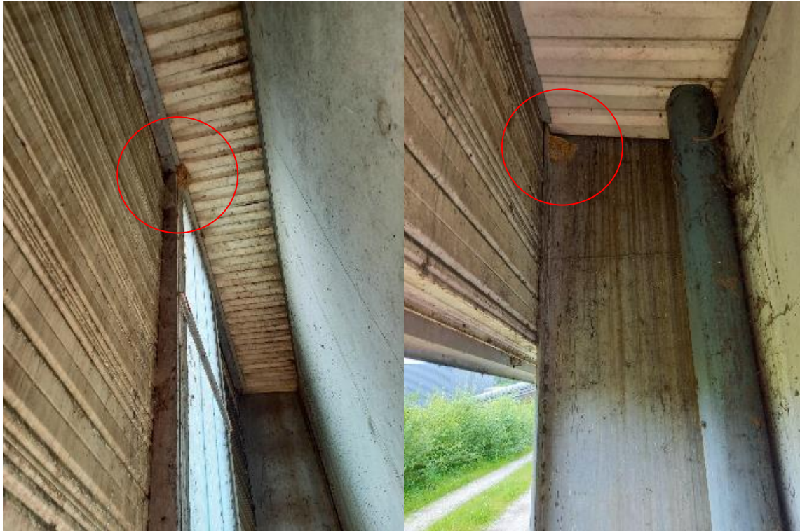
Figure 68. Illustration des nids d'Hirondelle rustique derrière le bardage
