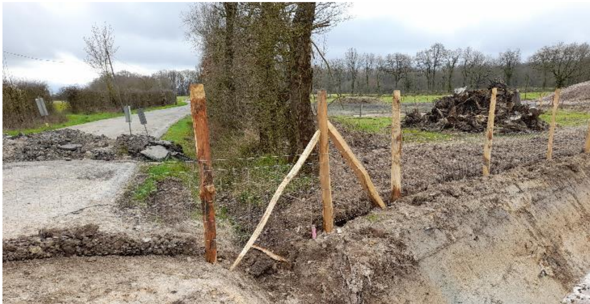
Figure 80. Illustration de mise en défens en phase chantier
