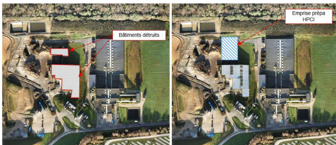
Figure 12. Agencement actuel de la plateforme de valorisation et localisation de l'emprise du futur bâtiment de valorisation & préparation matière
