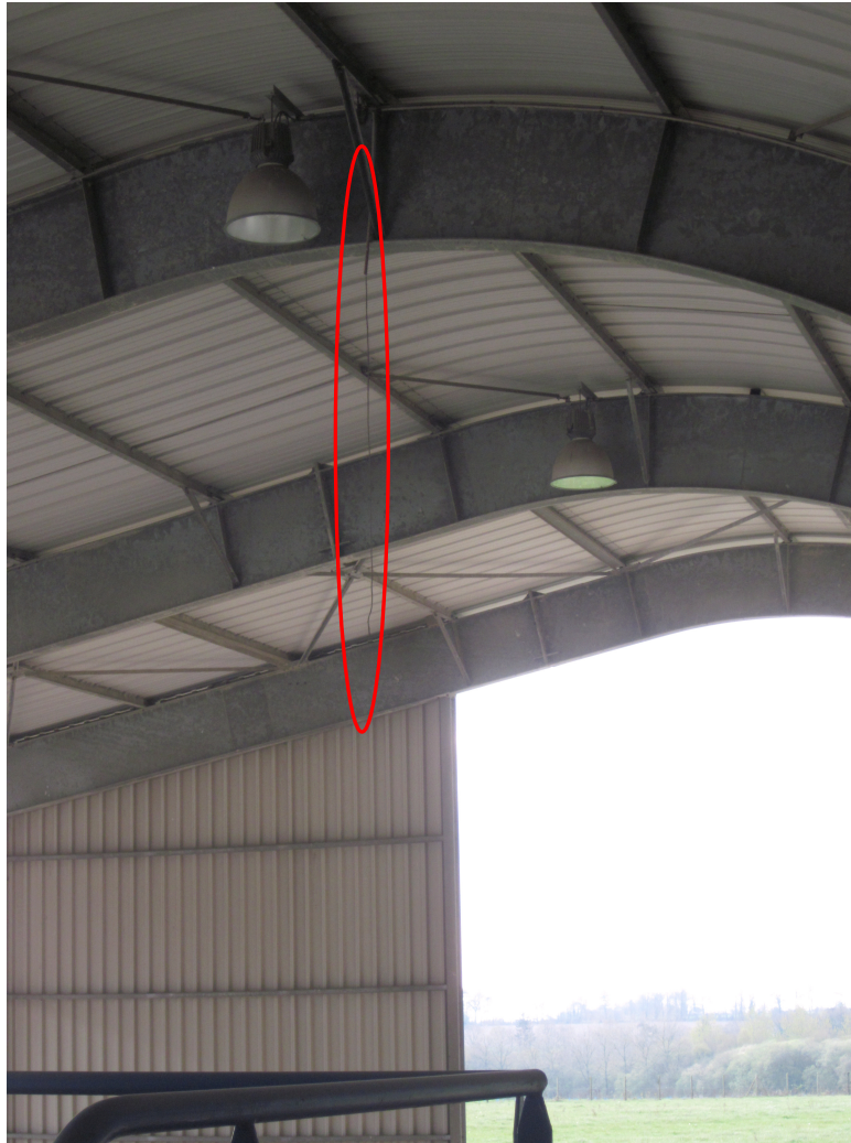
Figure IV- 15 : sonde de mesure de température dans le hall de réception du centre de tri
