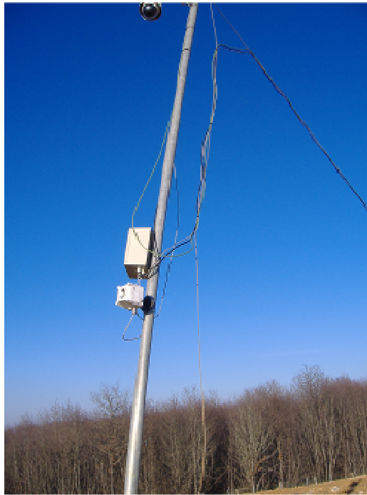
Figure IV- 16 : détecteurs infra-rouges de l'ISDND
