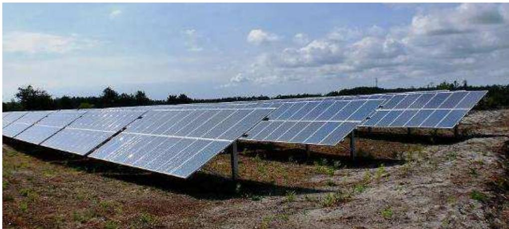
Figure 6 : Exemple de centrale photovoltaïque équipée de panneaux fixes – technologie cristalline
