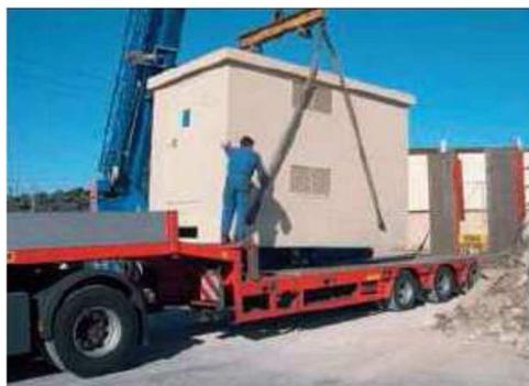
**Figure 21 : Déchargement d'un poste électrique**
