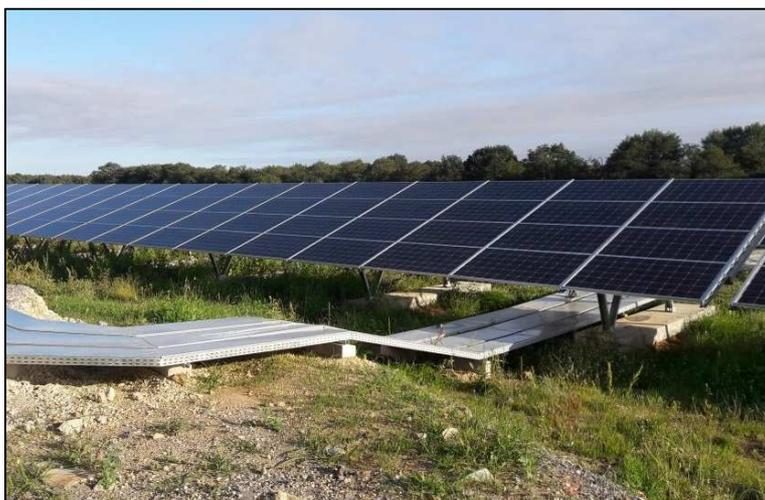
Figure 18 : Exemple de chemin de câbles
