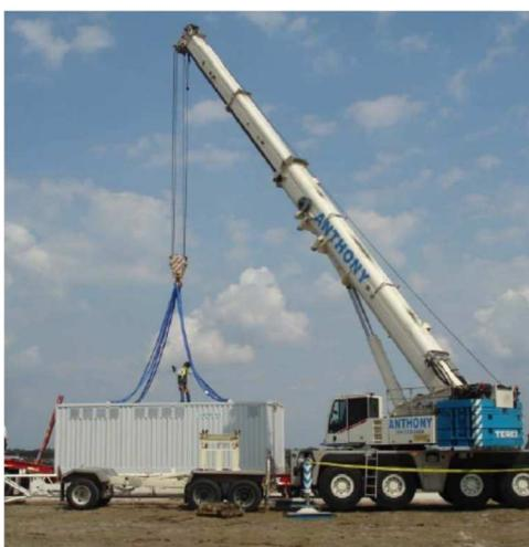
Figure 19 : Engin utilisé pour la pose des postes onduleurs
