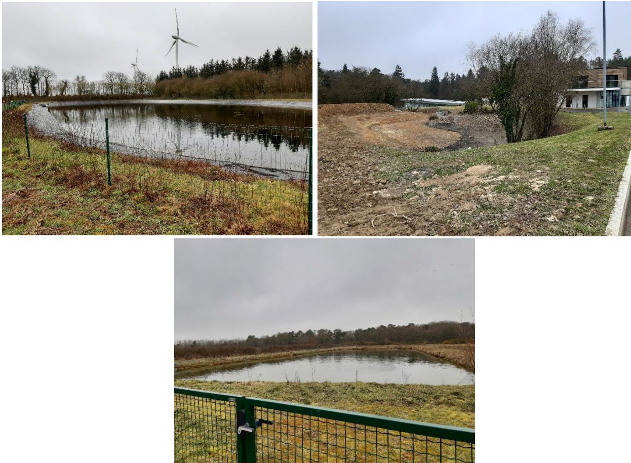
Figure 12 : Vues des bassins de stockage des eaux pluviales (dont un bassin en cours de création)
