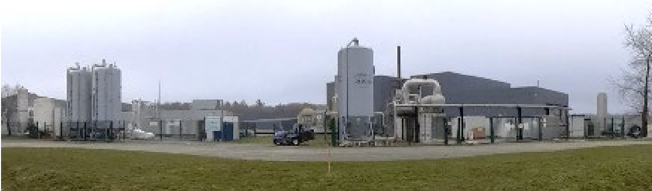
Figure 11 : Vue sur la plateforme de traitement du biogaz
