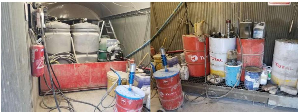
*Photo de stockage d'hydrocarbure sur cuve étanche (à gauche) ou dispositif à grillage collecteur (à droite)*
