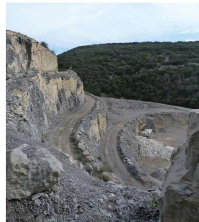
Vue 10 - Fosse organisée en fronts de 15 m et banquettes de 7 m jusqu'au fond (TN naturel) de la Combe des Graves
