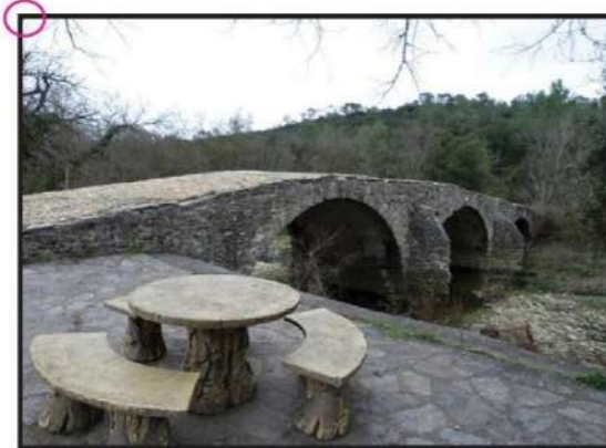
Pont de Cammaous à Vacquières
