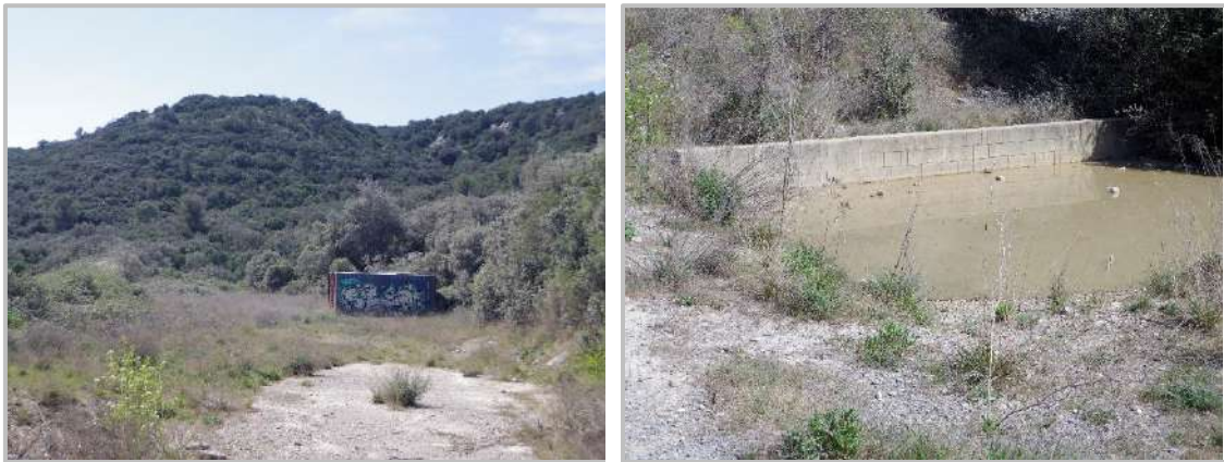
Photographie 9 : Bassin de rétention à l'entrée du site
