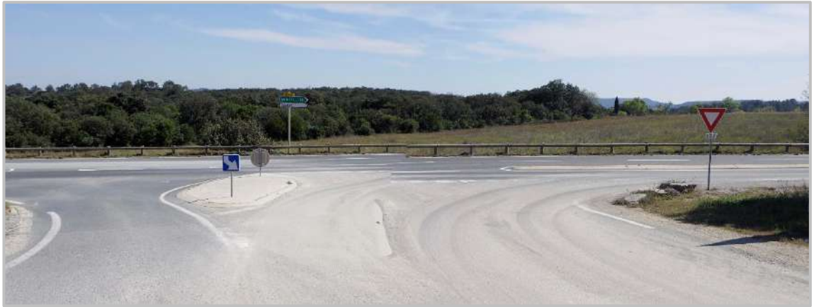
Photographie 1 : Carrefour au niveau de la RD45
