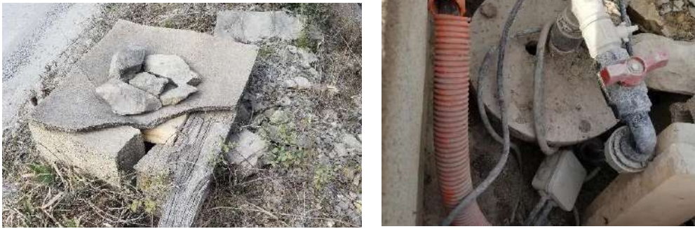
Figure 39 : Photo du forage F1 fermé (à gauche) et ouvert (à droite). La pompe est toujours en place dans le forage
