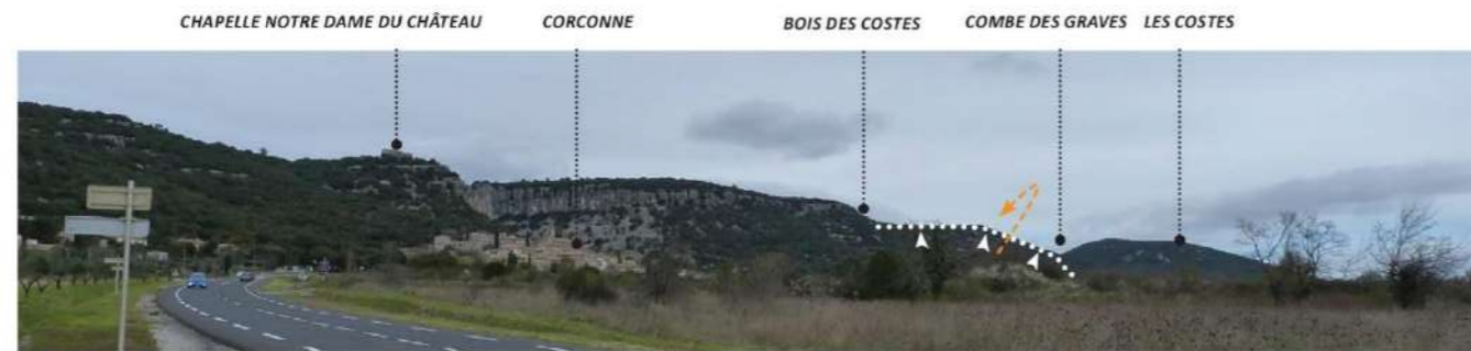
Vue 12 - Depuis le lieu-dit «Crémal» à Corconne sur la D45
