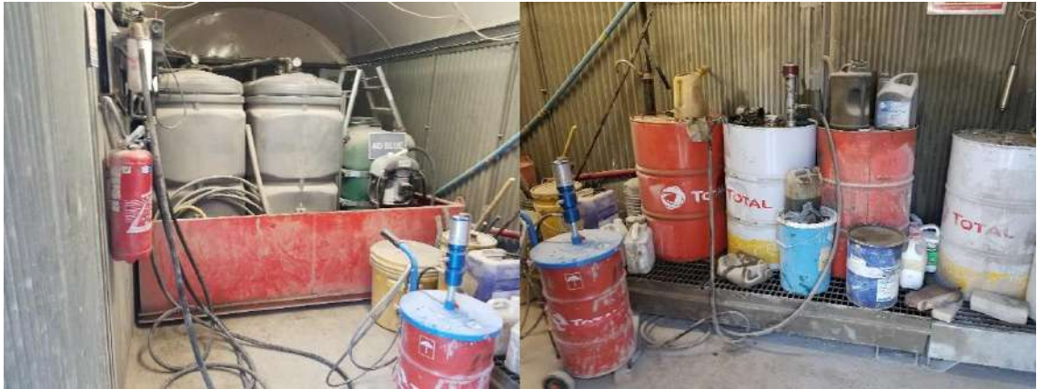
Figure 93 : Photo de stockage d'hydrocarbures sur une cuve étanche (à gauche) ou dispositif à grillage collecteur (à droite)
