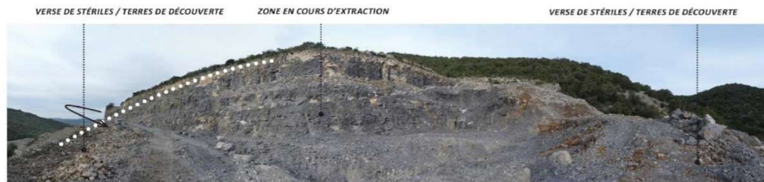
Vue 7 - Zone d'extraction actuelle masquée derrière la ligne de crête depuis l'entrée du site - Gestion des stériles en déballe en pied de fronts
