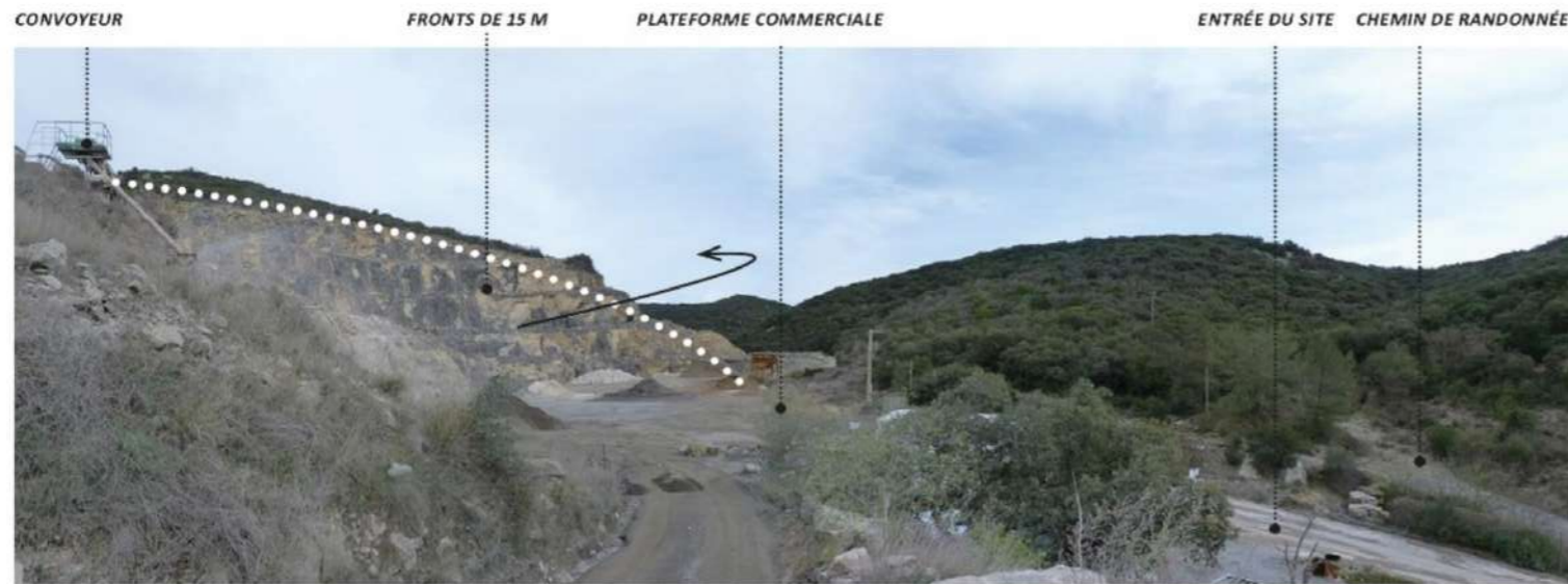
Vue 6 - Poursuite de l'exploitation derrière une ligne de crête
