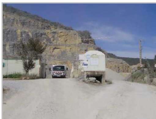
Photographie 4 : Entrée du site de la carrière
