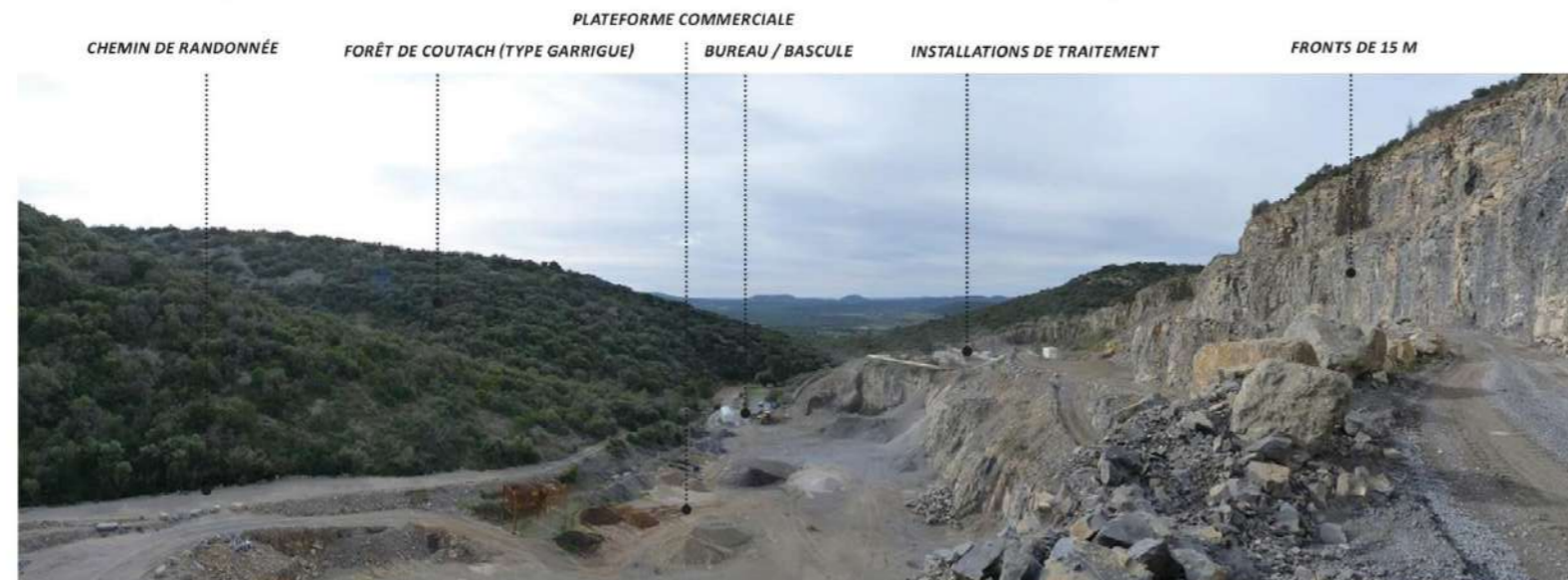
Vue 2 - Enclavement partiel de carrière au sein de la combe des Graves du Massif de Coutach (Direction Sud)
