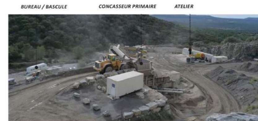
Vue 3 - Regroupement des locaux et installations en limite Sud
