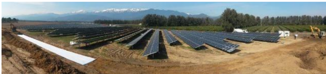
Figure 26 : Montage des structures sur pieux battus et des panneaux sur le chantier du projet Mortella, à Ghisonaccia (source : Akuo)
