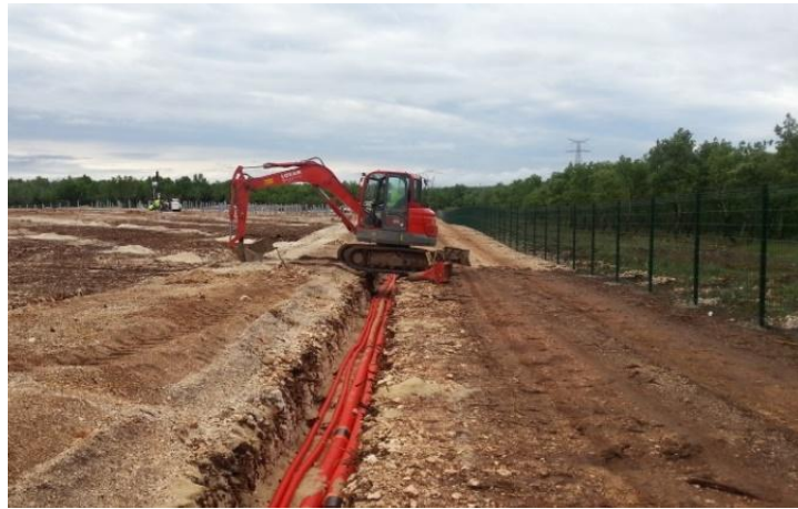
Figure 25 : Exemple de réalisation de tranchées électriques (Source : ECO-STRATEGIE)
