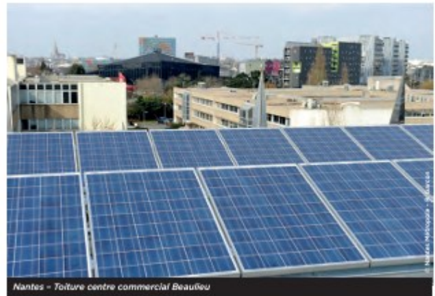
Nantes - Toiture centre commercial Beaujeu
