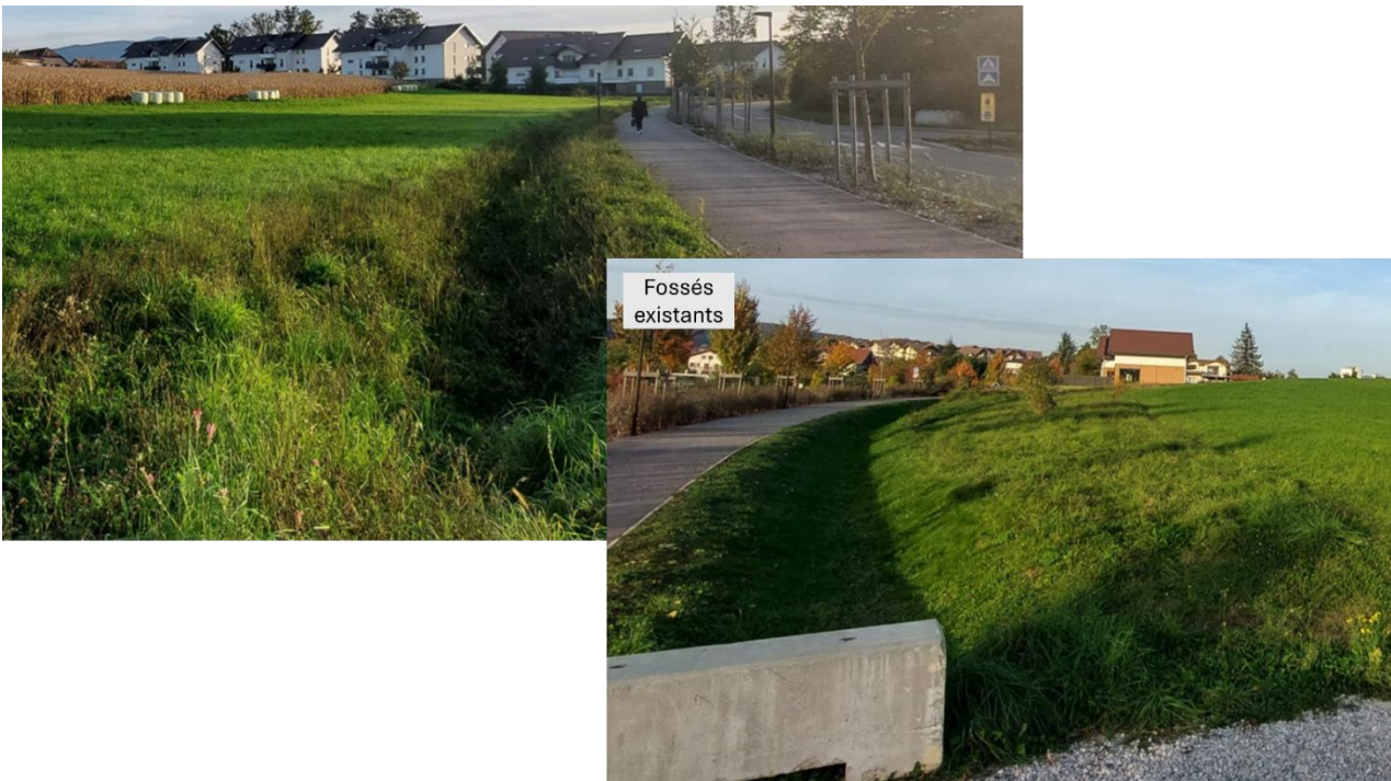
Figure 4 : Vues sur les fossés existants à l'aval du projet
