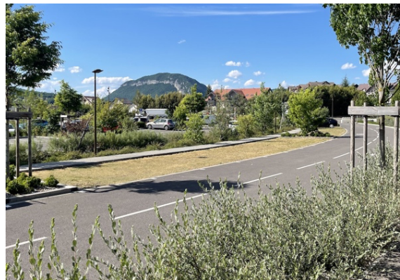
Exemple de stationnement perméable et paysager réalisé sur Parc'Espace en evergreen ( mélange de graminées, sedum, thym, .... )
