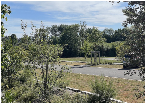
Exemple de stationnement perméable et paysager réalisé sur Parc'Espace en evergreen ( mélange de graminées, sedum, thym, .... )
