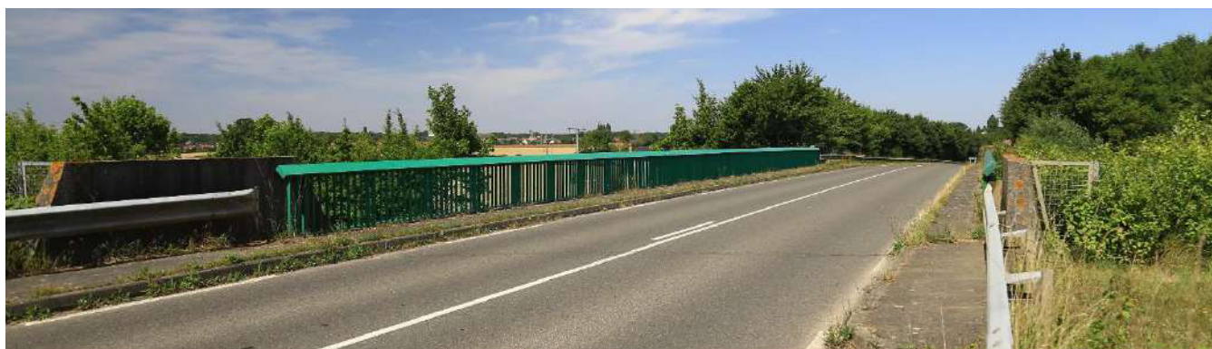
Photo 27. Village d'Abbeville-Saint-Lucien depuis le pont de la RD9 surplombant l'A16
