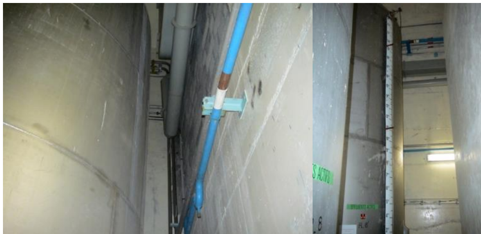
Figure 20. Photographies des cuves R8 et R8' au niveau -2 du bâtiment 216
