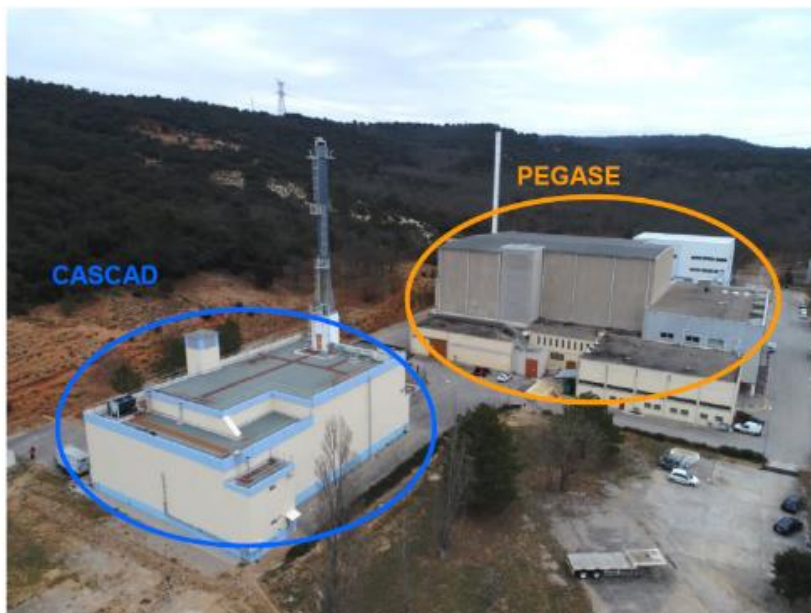
Figure 3. Vue aérienne sur les installations PEGASE et CASCAD
