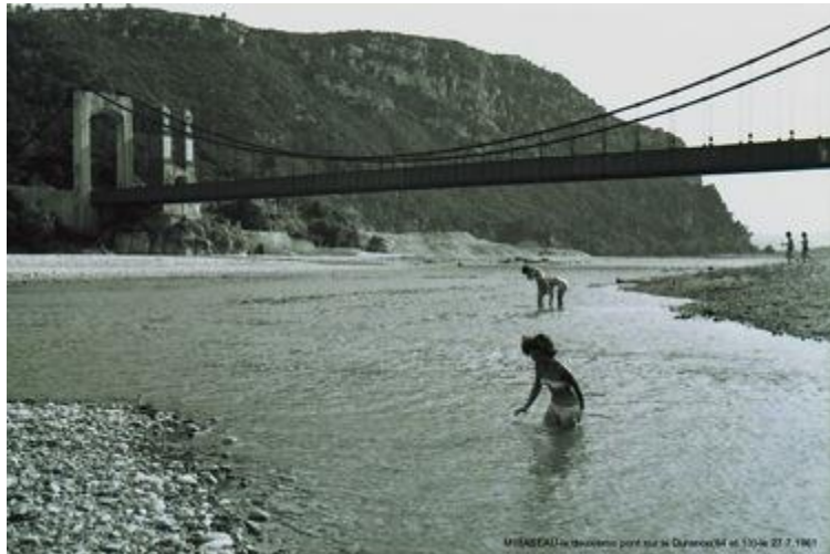
Le troisième pont de Mirabeau (en 1961)
