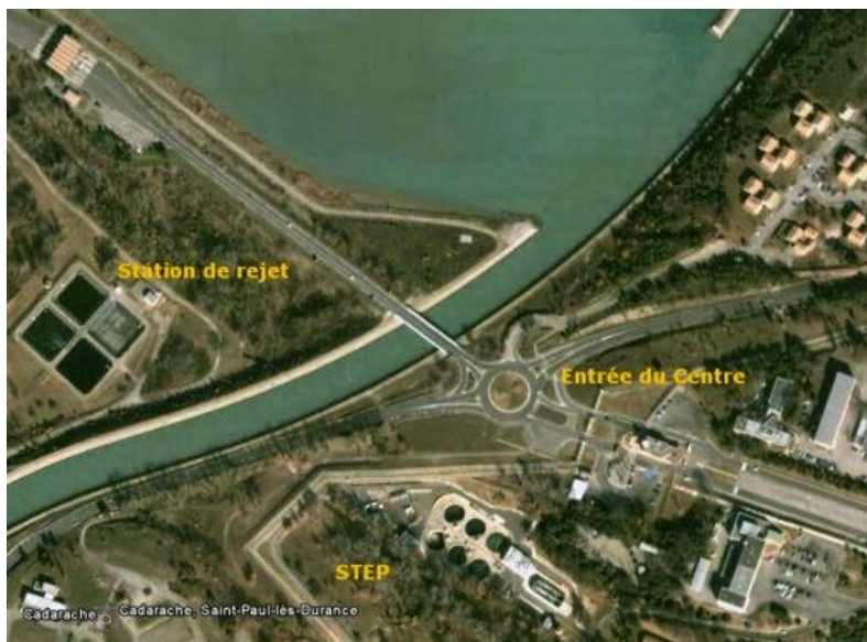
Figure 135 : Vue aérienne de la Station d'épuration du Centre (STEP) et de la station de rejet en Durance
