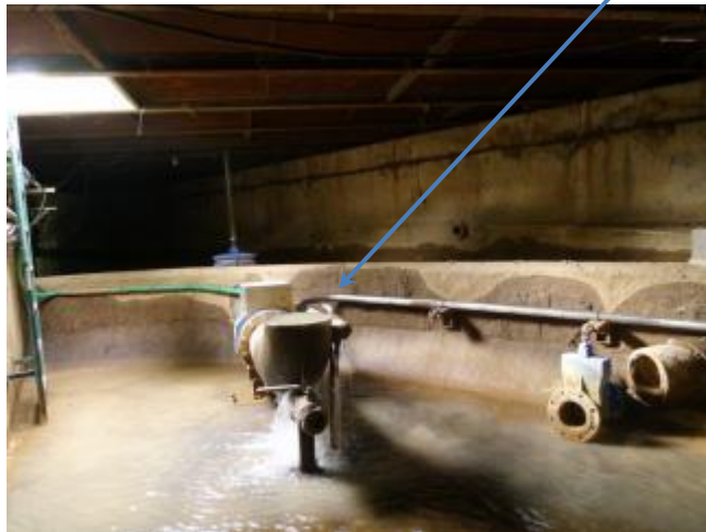
Figure 69 : Schémas et photo de la station de mesure aval du débit du Ravin de la Bête
