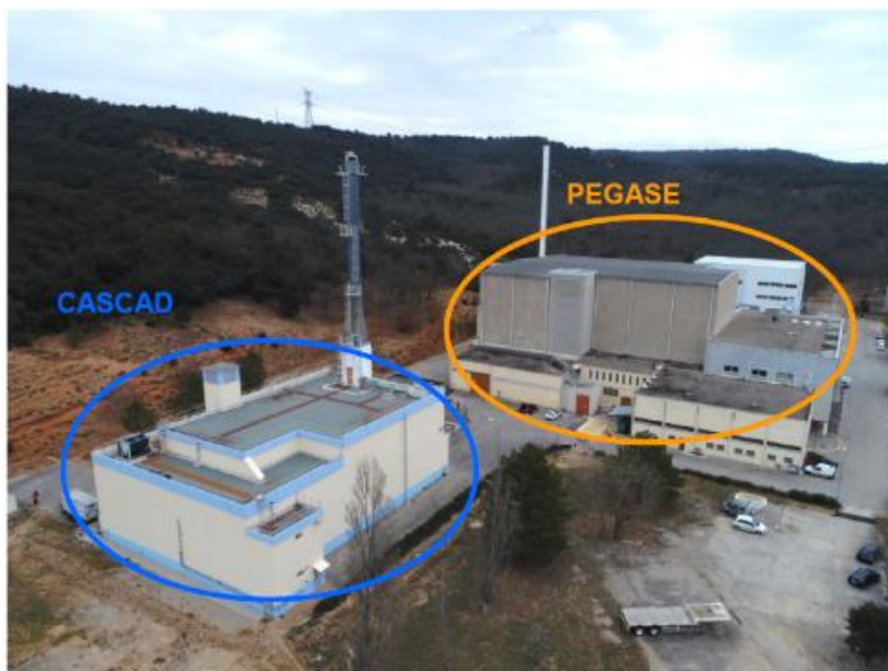
Figure 3. Vue des installations d'entreposage PEGASE et CASCAD après le démontage du réacteur PEGASE (actuel)
