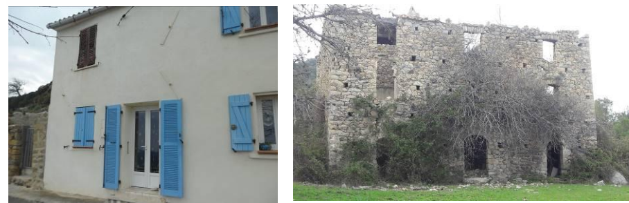
Une maison de village rénovée Une ruine
