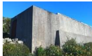
réservoir du Village
