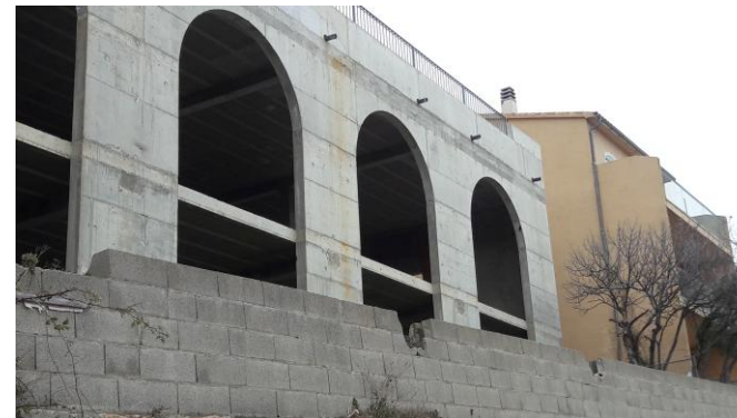
Chantier en cours au village.
