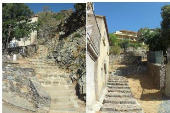
Exemples de cheminements dans la pente (Asco)
