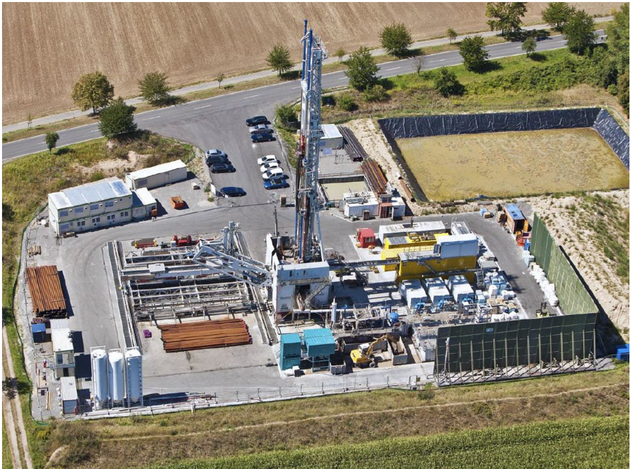
Figure 2.3 : Exemple d'implantation d'un chantier de forage
