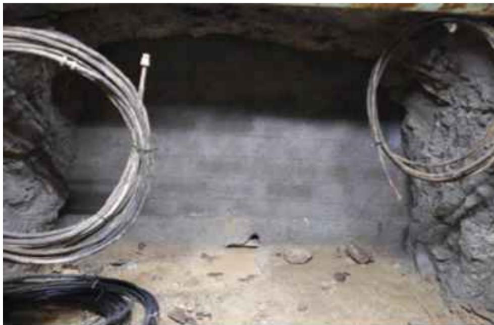
Cloisonnement/ fermeture d'un accès
