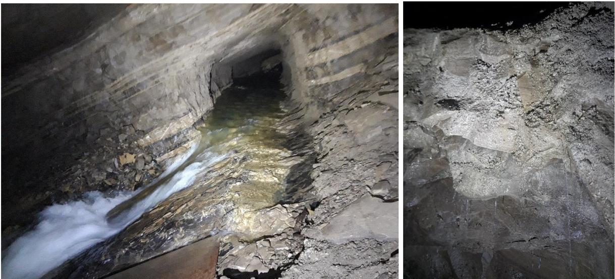
Figure 4 : Venue d'eau à l'extrémité du quartier Sud. Ruissellement d'eau à la base d'une chambre.
