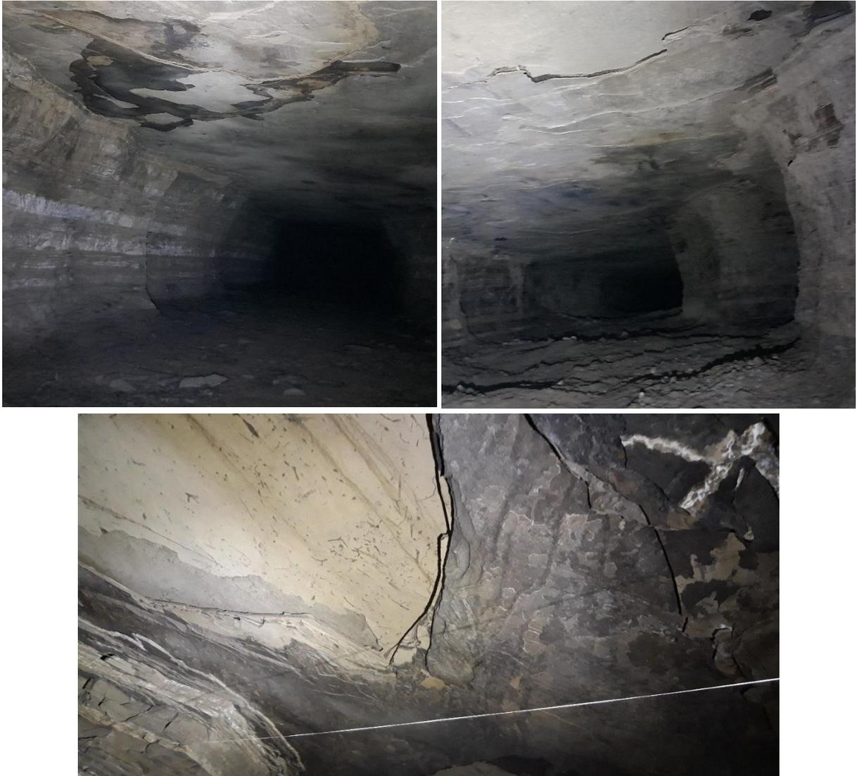
Figure 3 : Plaques tombées ou prêtes à chuter, sur des surfaces de plusieurs mètres carrés
