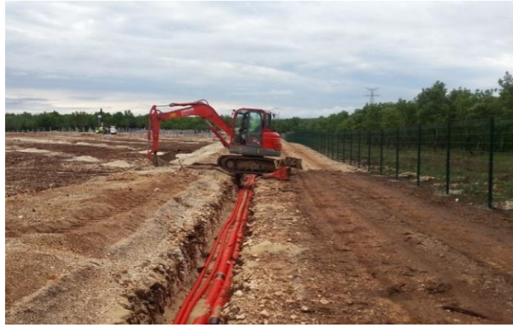
Figure 60 : Exemple de réalisation de tranchées électriques (source : ECO-STRATEGIE)
