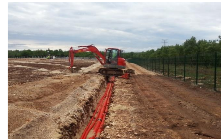
Figure 94 : Exemple de réalisation de tranchées électriques (source : ECO-STRATEGIE)
