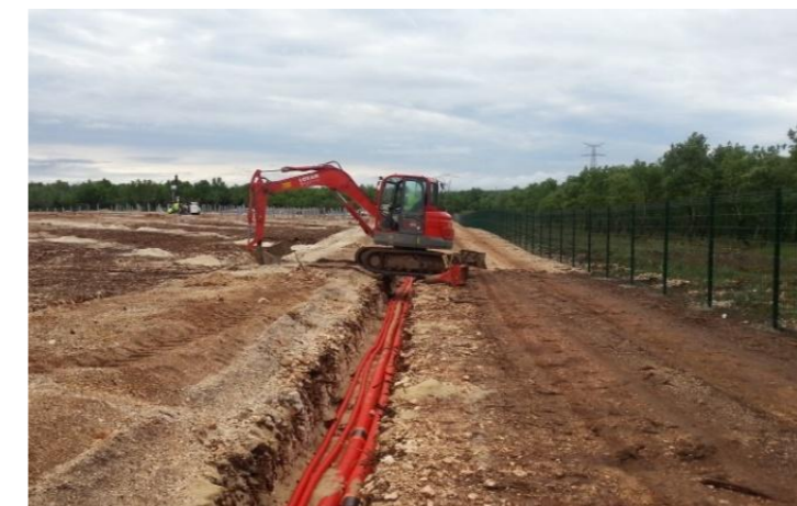
Figure 44 : Exemple de réalisation de tranchées électriques (source : ECO-STRATEGIE)
