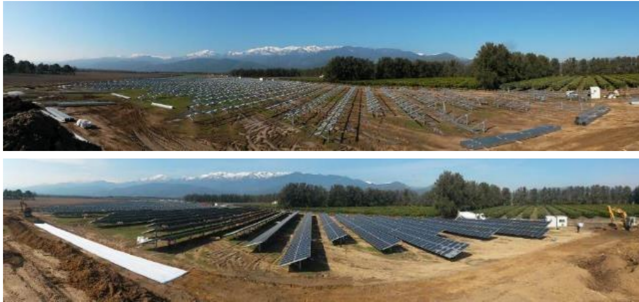
Figure 45 : Montage des structures sur pieux battus et des panneaux sur le chantier du projet Mortella, à Ghisonaccia (source : Akuo)
