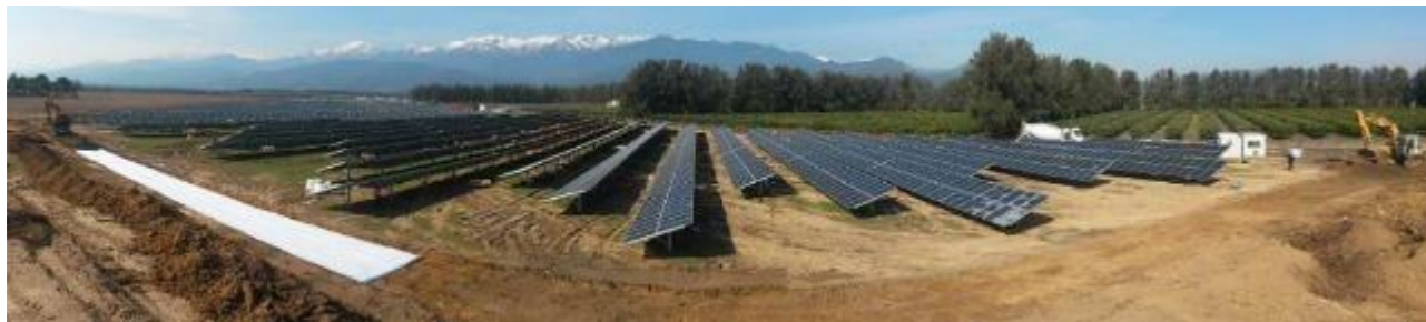
Figure 61 : Montage des structures sur pieux battus et des panneaux sur le chantier du projet Mortella, à Ghisonaccia (source : Akuo)
