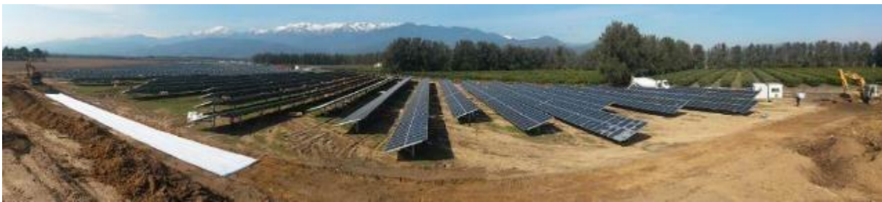
Figure 95 : Montage des structures sur pieux battus et des panneaux sur le chantier du projet Mortella, à Ghisonaccia (source : Akuo)
