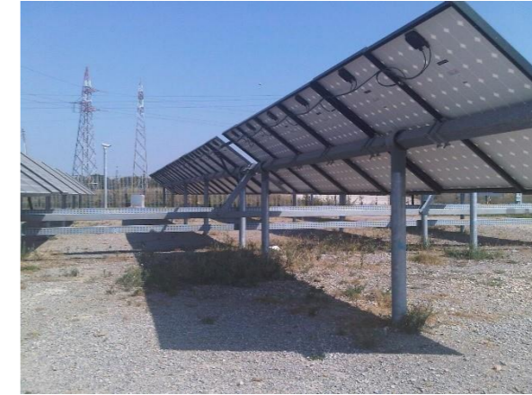
Figure 11 – Table de modules de type tracker
