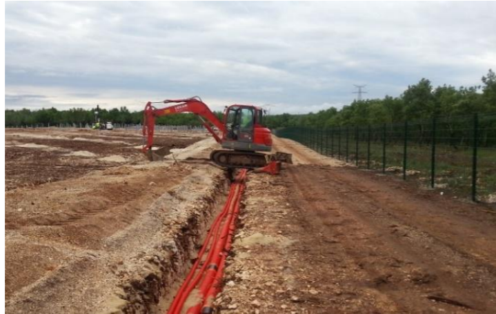
Figure 76 : Exemple de réalisation de tranchées électriques (source : ECO-STRATEGIE)
