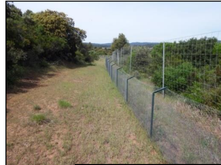
exemple de grillage doublé en sa partie inférieure afin d'éviter le passage de tortues © Joseph CELSE
