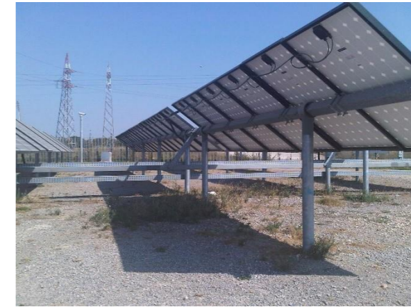
Figure 11 – Table de modules de type tracker
