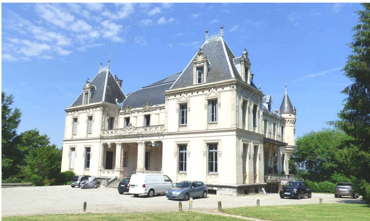
Vue actuelle de la façade sud-est (entrée) et retour nord-est
