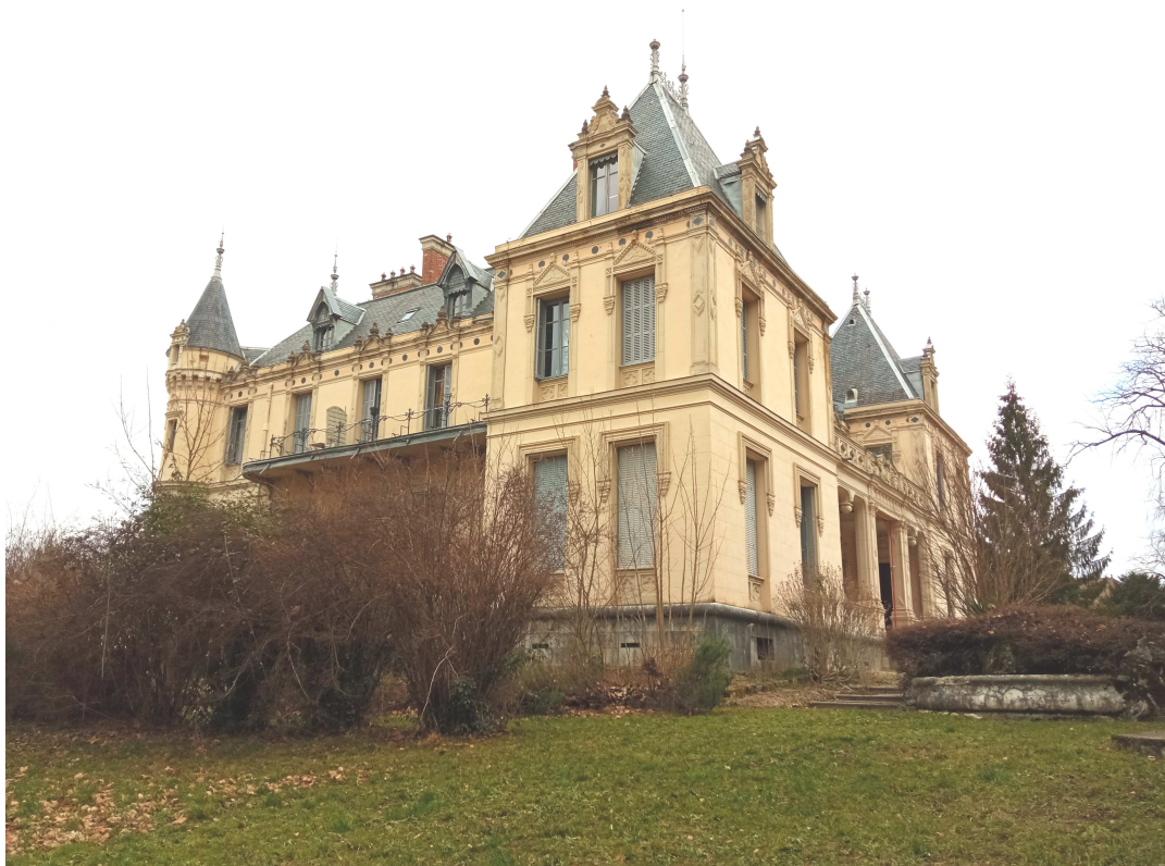
Angle sud du château
