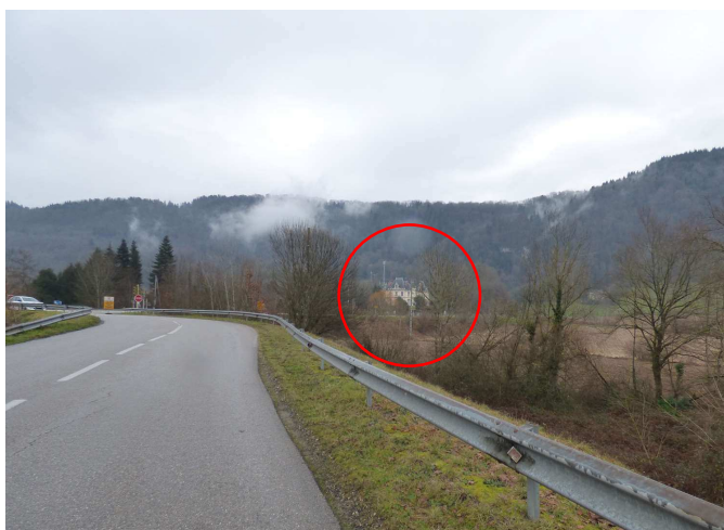
Vue depuis le sud du hameau (route D203)
