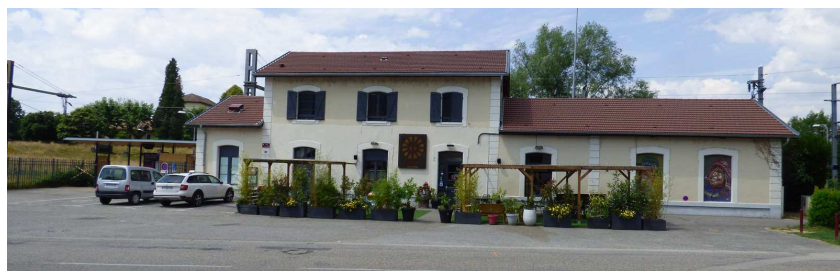
Actuelle gare réaménagée en bar « lounge »
