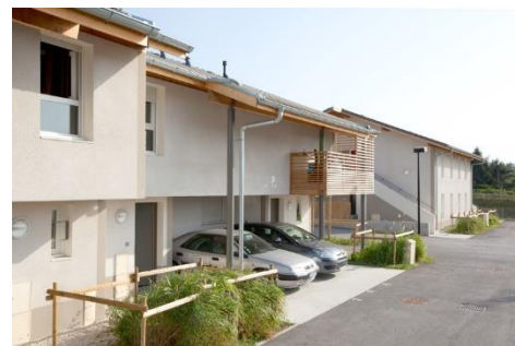
Opération de logements groupés locatifs sociaux « Les Liparis » à Saint-Jorioz (74)
