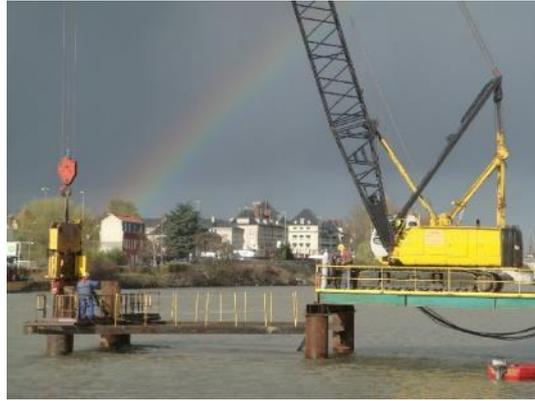
Figure 12: Réalisation d'une passerelle par avancement
