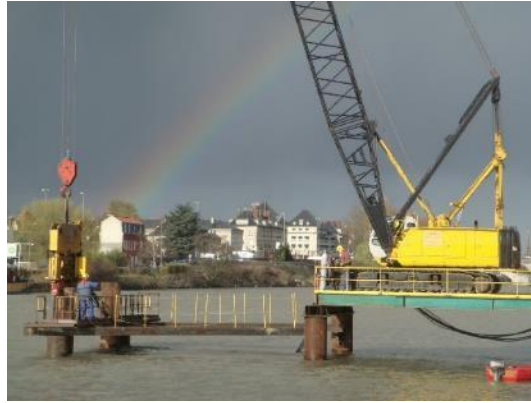
Figure 63: Réalisation d'une passerelle par avancement
