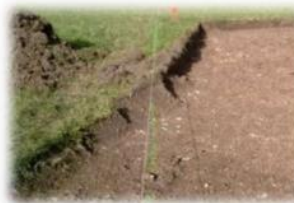
Terre végétale décapée sur l'emprise des travaux
