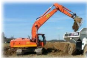
Décapage et chargement de la terre végétale
