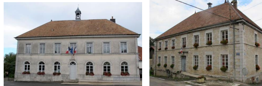
À gauche, la mairie-école de Déservillers ; à droite, celle de Bolandoz (source : CAUE25).
