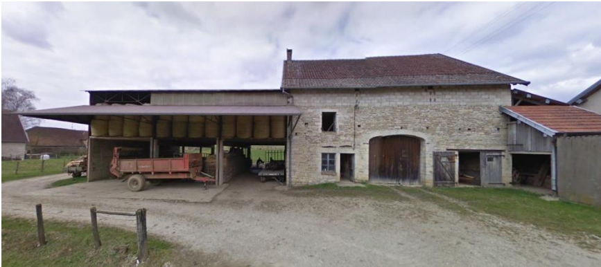
Exemple d'extension d'une ferme à 3 travées à Liesle permettant le maintien de l'activité (source : Google maps).
