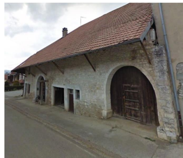
Exemple de débord de toiture soutenu par des consoles à Longeville (source : Urbicand)
