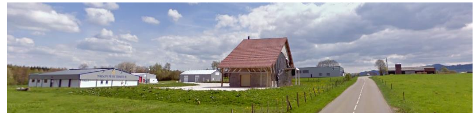
En haut : Entrée du village de Saules : une perception du bourg historique effacée par les nouvelles constructions à usage d'activité (source : Google)
