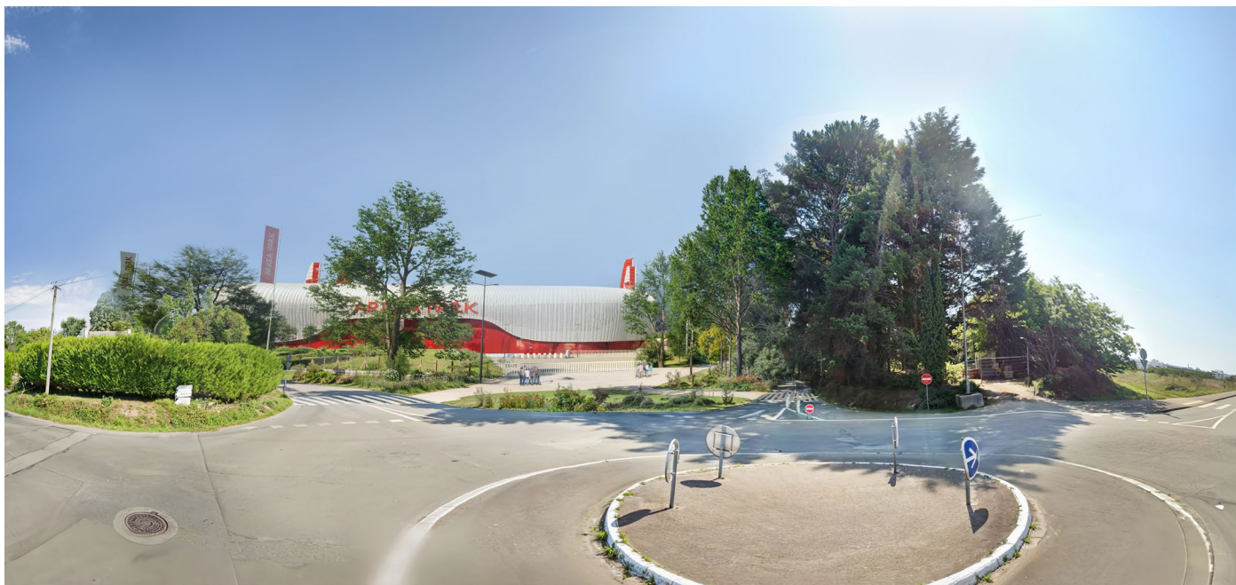
Figure 21 – Vue du parvis Nord – Depuis le rond-point Keradrien – Agence François DE LA SERRE
