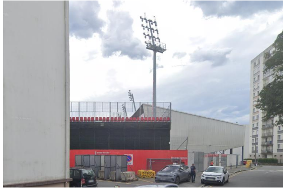
Figure 130 : Vue du stade et de ses interfaces urbaines disparates depuis la rue de Douarnenez (Source : Googlestreetmap)
