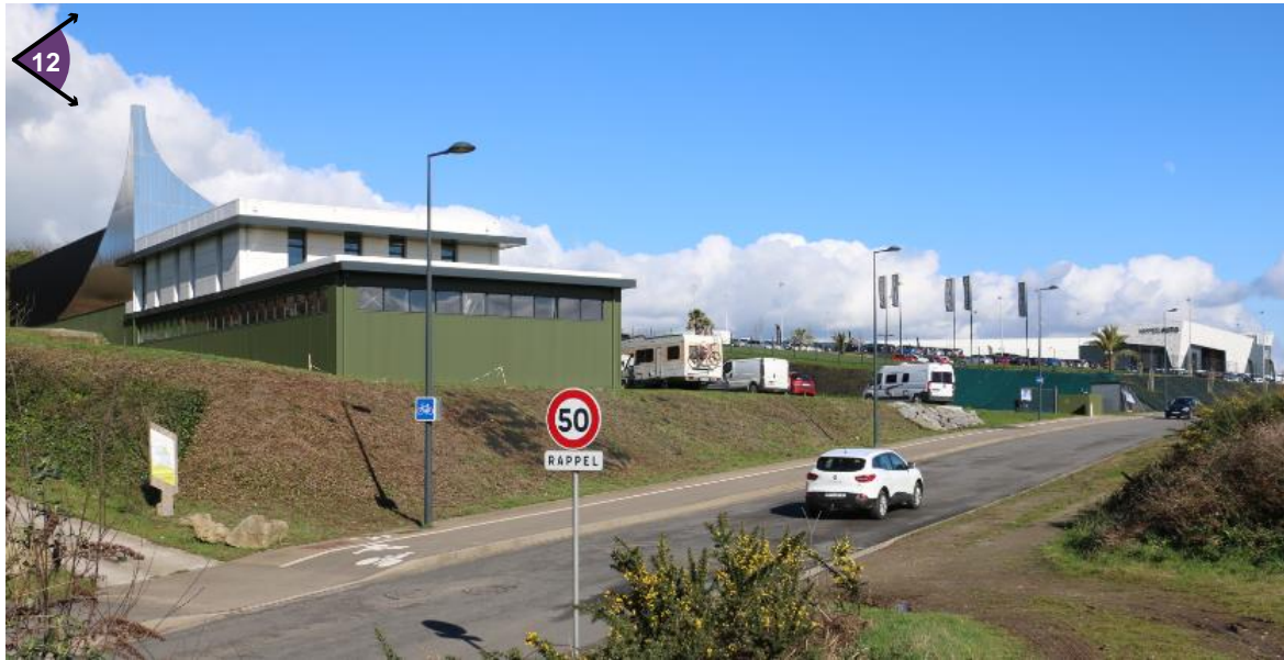
Zone d'activités au Nord du site d'étude (ZI de Kergaradec)
