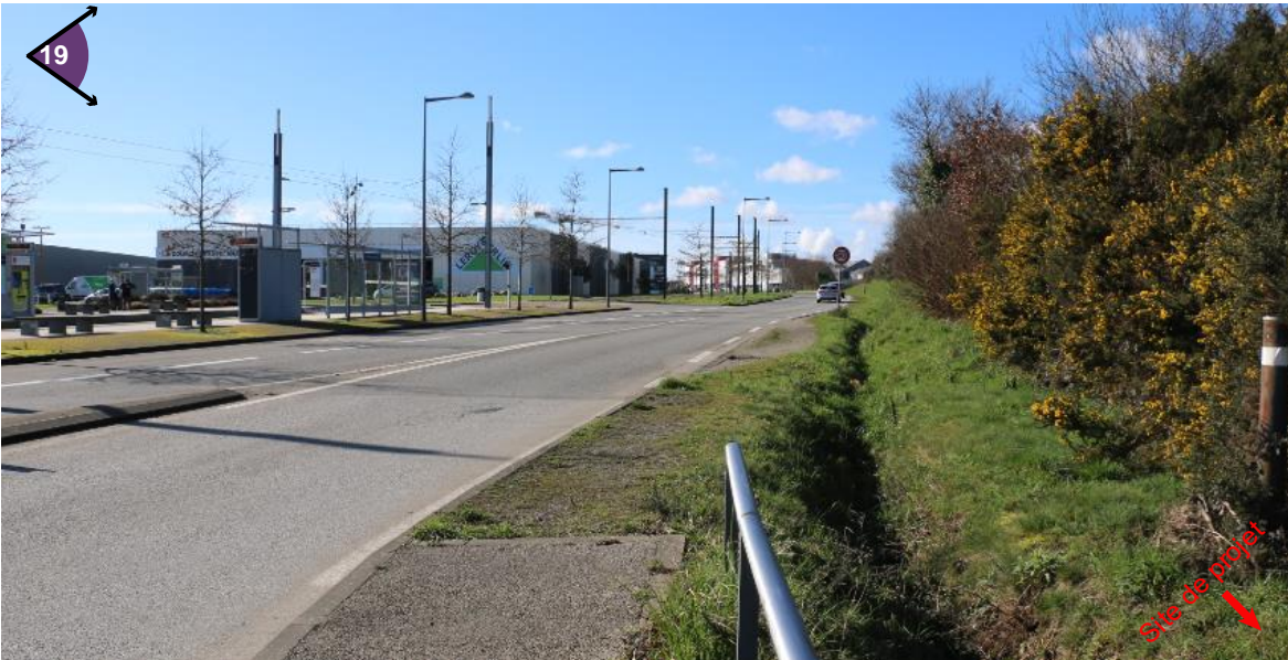
Vue en direction de l'Est sur le boulevard François Mitterrand (RD205) au niveau du Terminus de la station de tram (Porte de Guipavas).
