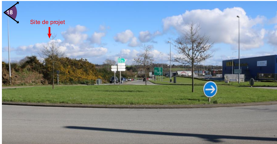
Vue en direction de l'Est sur la RD205 entre l'intersection avec la rue Keradrien et le rond-point de Querlanou à l'horizon
