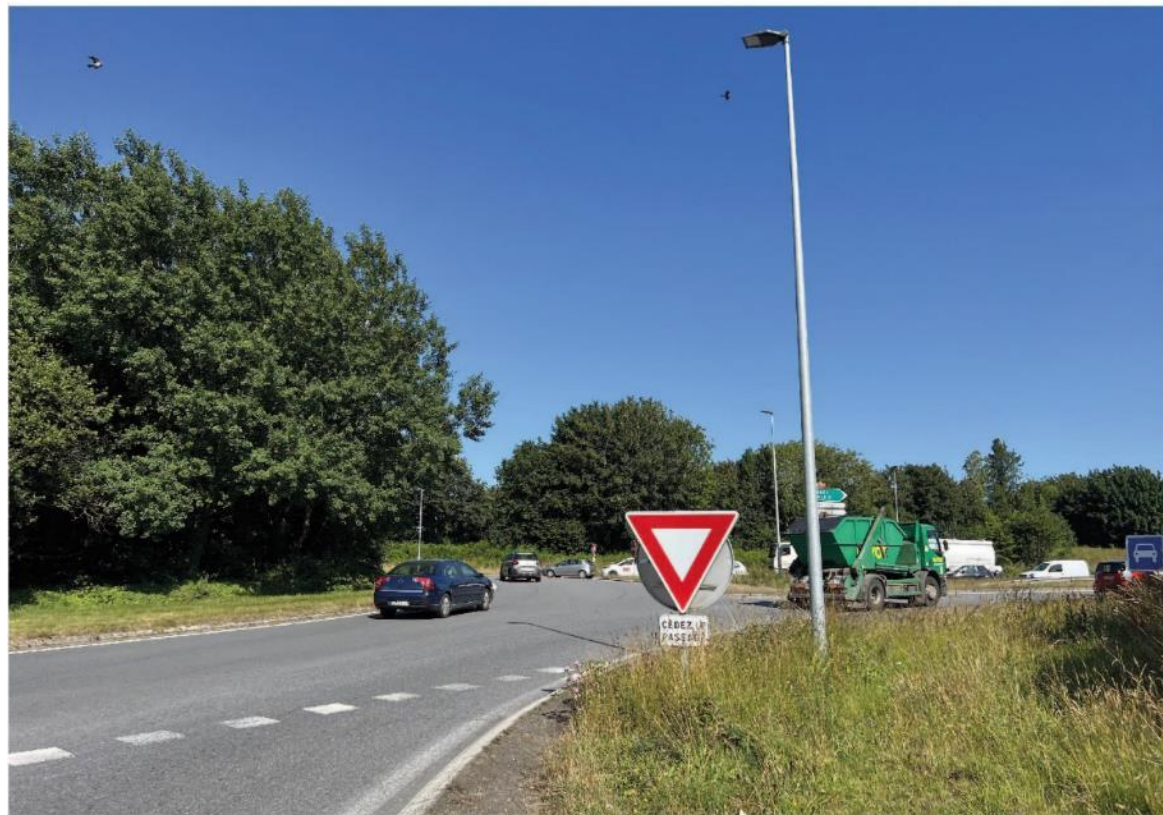
Vue 16 - Etat initial : Depuis l'Est - en arrivant par la RN265
