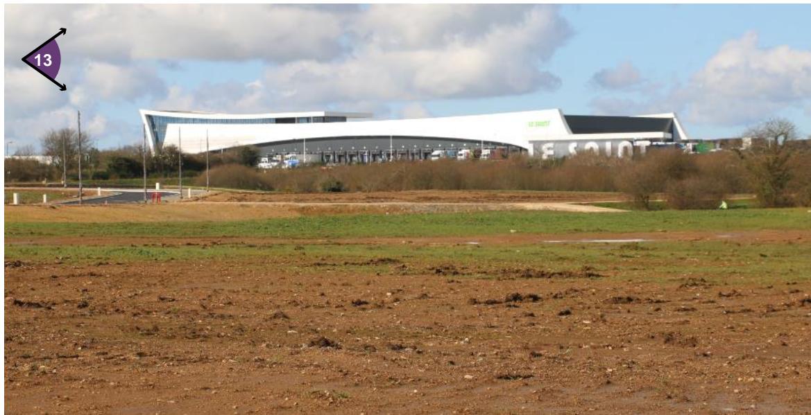
Secteur d'activités en cours d'aménagement en hauteur sur le plateau (rue Eric Tabarly)
