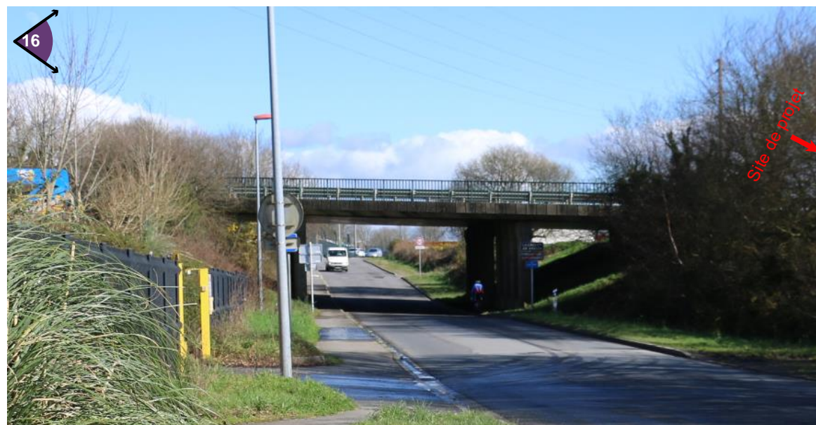
Le franchissement de la RN265 au niveau de la rue Alfonse Penaud, en limite Nord-Est- du site d'étude.
