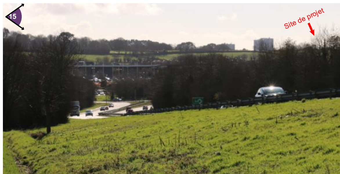
La RN265 s'inscrit en remblai en limite Est du site, le site est cependant masqué par une haie arborée dense
