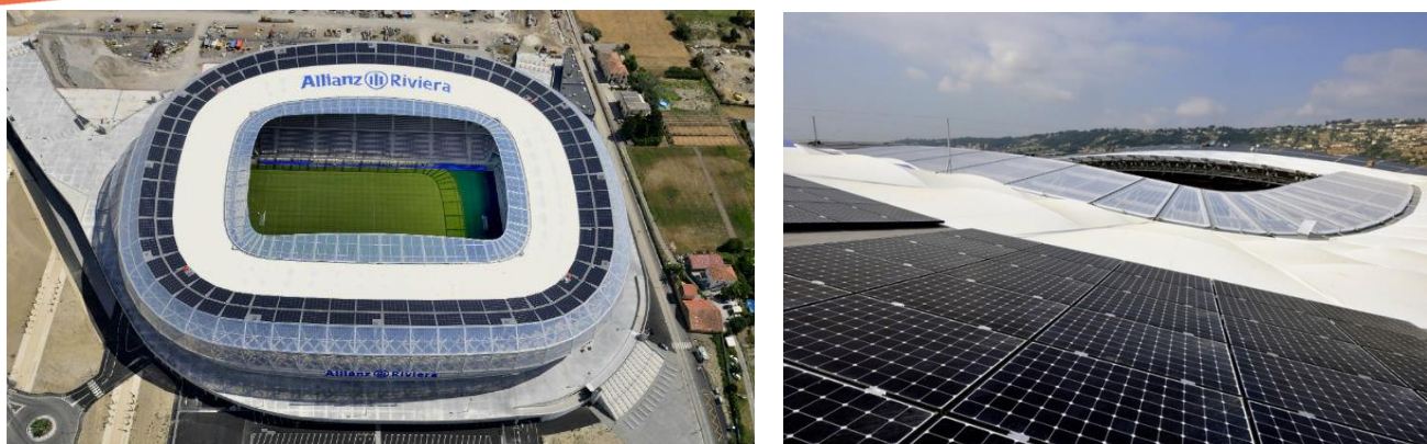
Figure 3 Panneaux photovoltaïques en toiture – Stade de Nice
