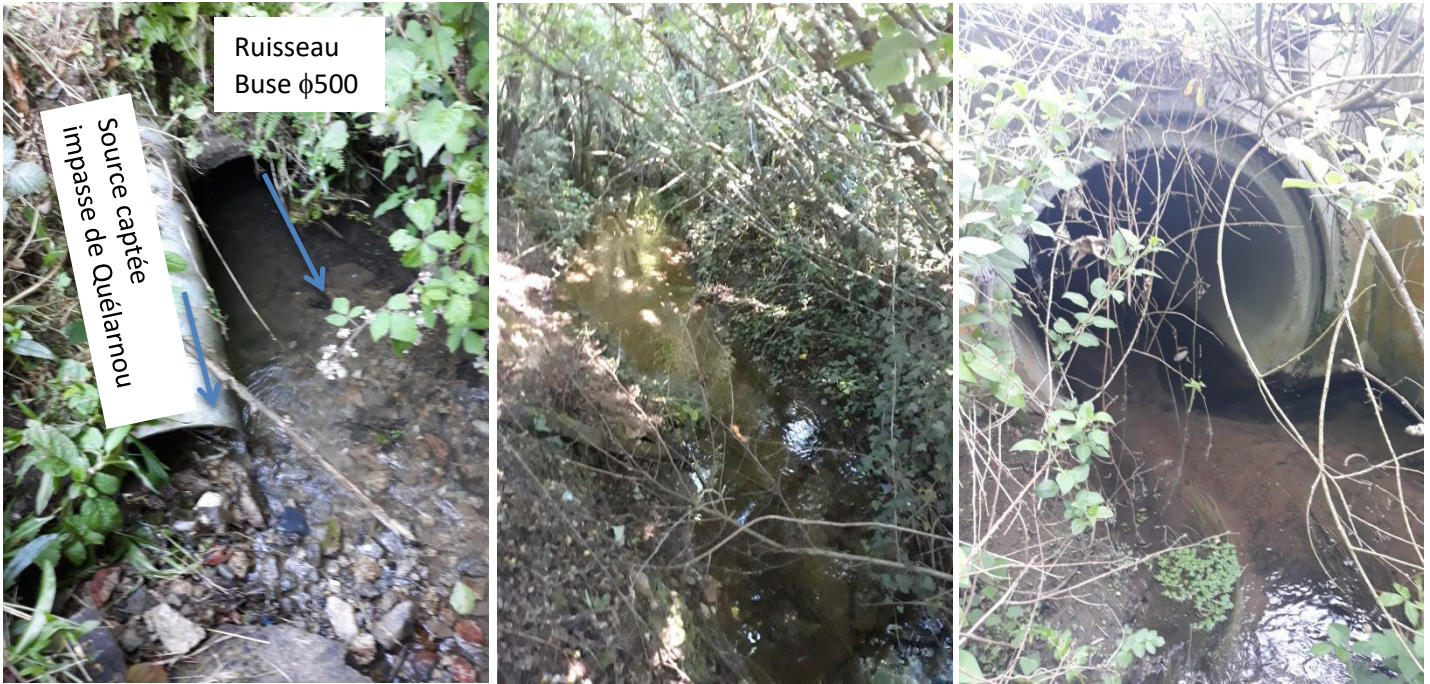
Aval buse φ500 (n°1)
