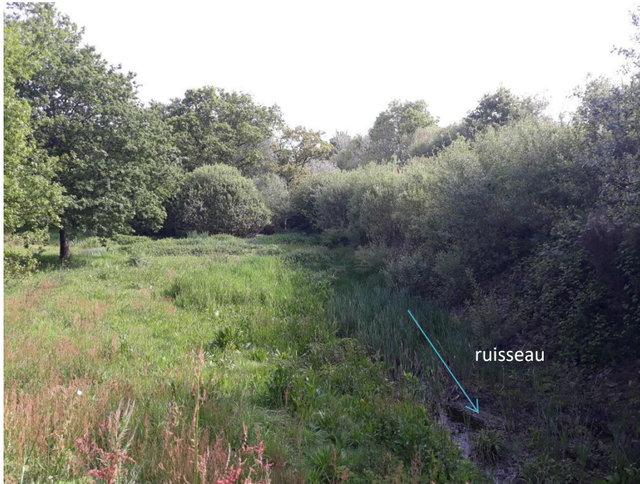
Bassin de rétention des eaux pluviales de la zone de Kergaradec III
