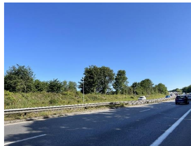
La RN 265 en léger déblais ou à niveau dans sa section sud limitant les vues vers le site d'implantation du grand stade.
