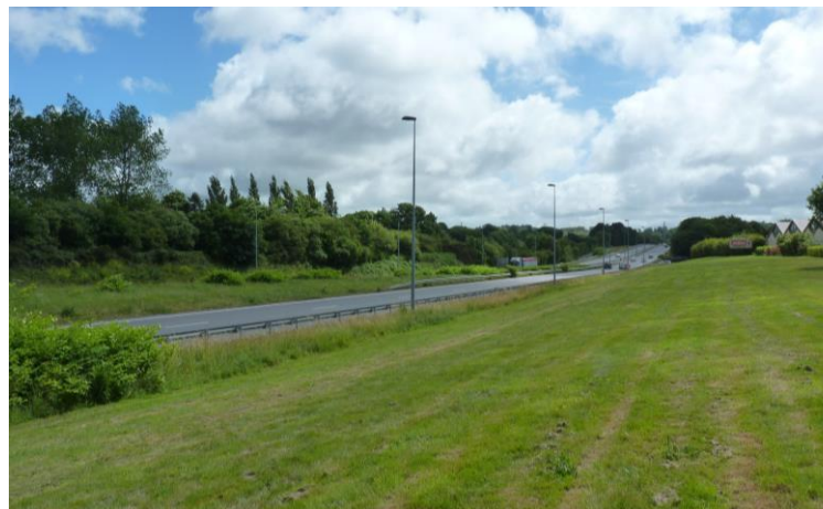
Vue de la RN 265 depuis le Rond-point de Quelarnou (SCE 2022)
