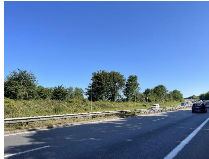
La RN 265 en léger déblais ou à niveau dans sa section sud limitant les vues vers le site d'implantation du grand stade.
