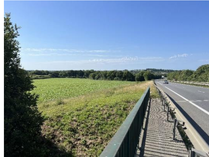
La RN 265 en remblai sur sa section nord, ouvrant les vues vers le sud-est
