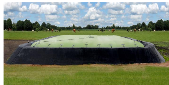
Figure 17 : Réserve semi enterrée (source Labaronne Citaf)
