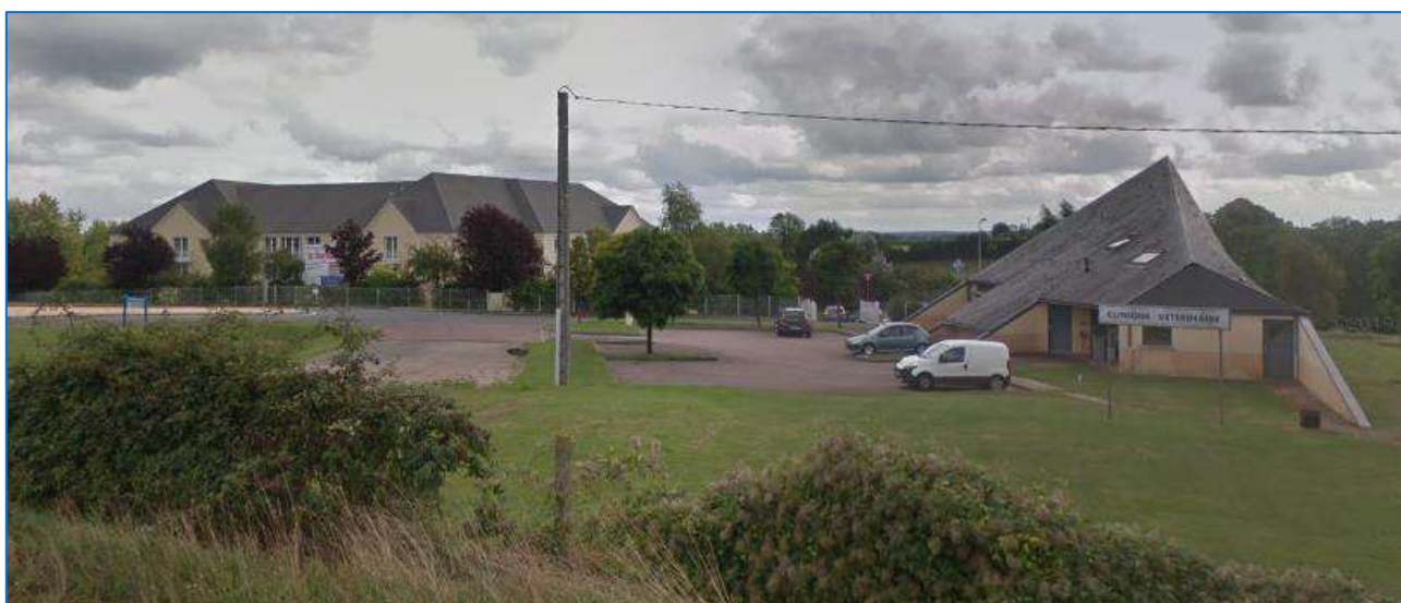
Maison de retraite la Barillière (à gauche) et la clinique vétérinaire (à droite)
