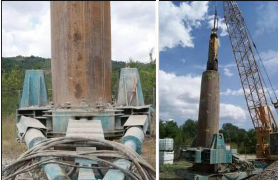
Figure 2 : Photographies d’un louvoyeur avec la méthode BENOTO (RESURGENCE)
