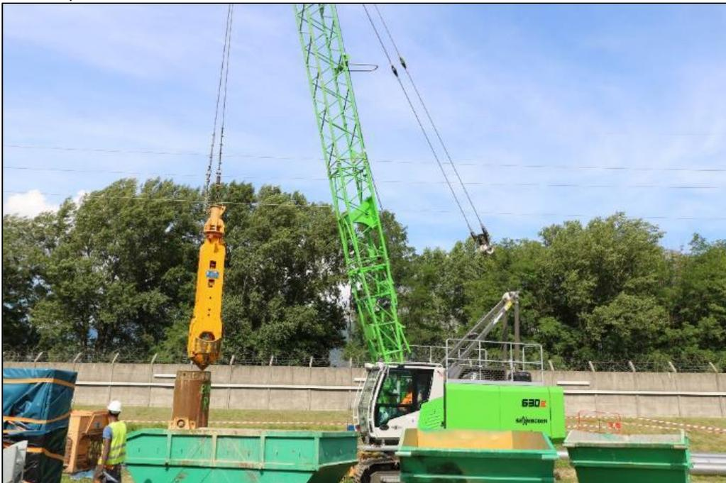
Figure 1 : Photographie d’une grue avec la méthode BENOTO (RESURGENCE)
