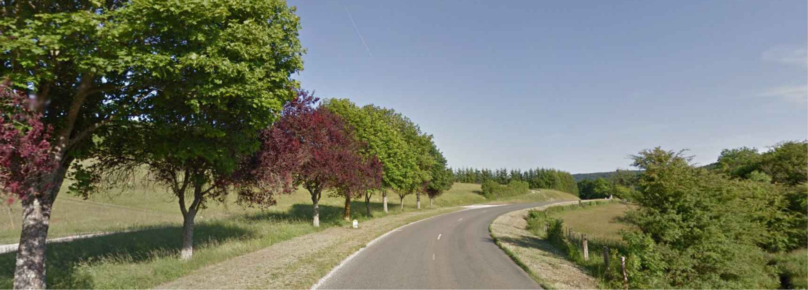
PHOTO LOINTAIN ACCES POSTES LIVRAISON
