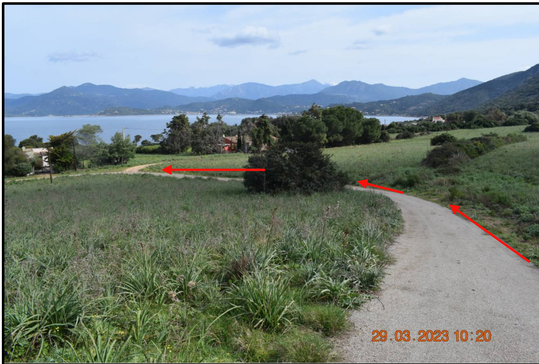
Figure n°74 : Vue de la partie bitumée de l'accès au rivage de « Pevani 4 ».
