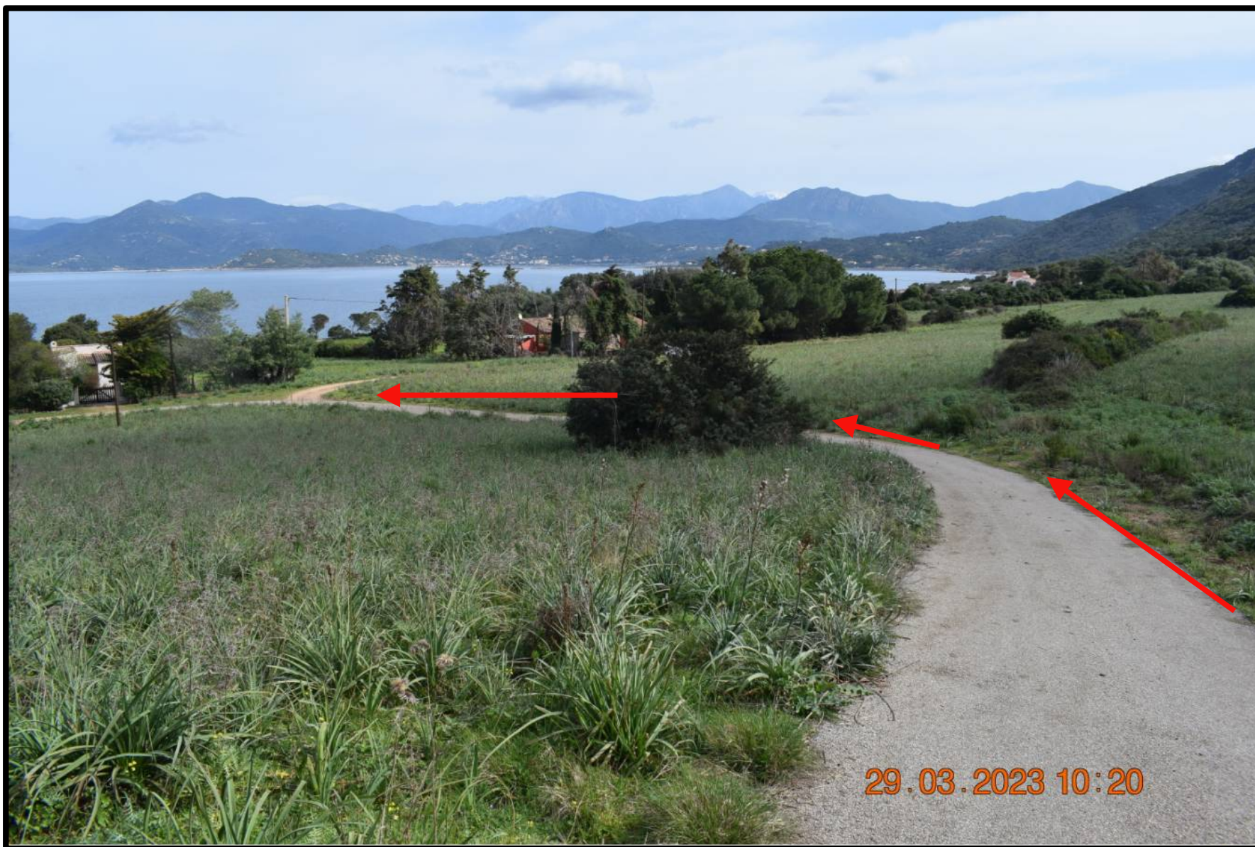
Figure n°85 : Vue de la partie bitumée de l'accès au rivage de « Pevani 5 ».
