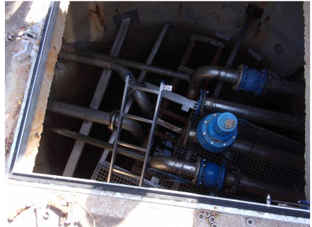
*Intérieur de l'ouvrage avec la plate forme métallique et les différentes canalisations d'exhaure*
