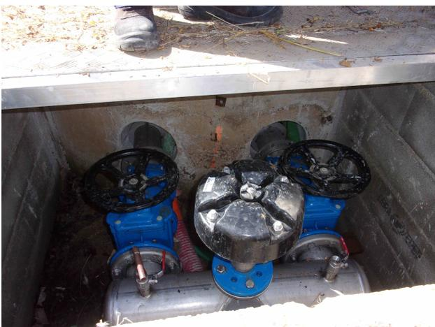
*Local situé à proximité du puits et refermant les vannes ainsi qu'un robinet de prélèvement pour analyses*
