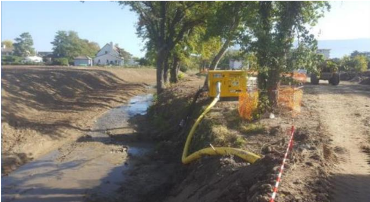
Figure 112 - Dérivation des eaux d'un cours d'eau, Notice de gestion des terres AVP Renaturation TLG, décembre 2020
