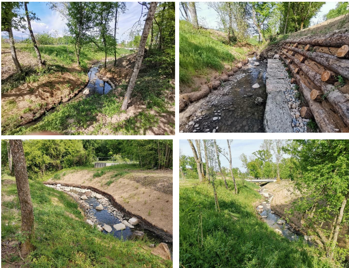
Figure 38 – Exemples de travaux de renaturation du Nant issus de la phase 1 d'aménagement de la ZAC, ALTO STEP, mai 2022
