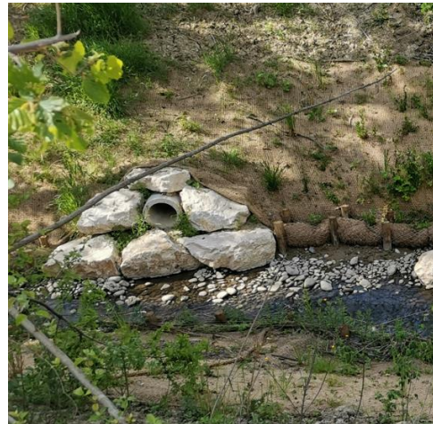
Figure 21 - Ouvrage type tête d'aqueduc en pierre naturelle, Notice technique AVP Tramway (02.2022) et exemple d'ouvrage type tête d'aqueduc en pierre naturelle sur la renaturation du Nant sur Paimboeuf/Tire (05.2022), ALTO STEP
