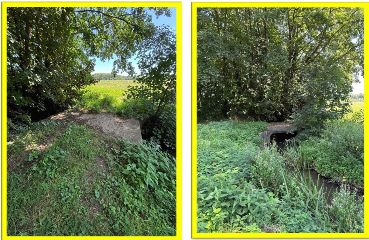
Figure 46 : Photos de l'ouvrage agricole sur la rue de Meyrin, ABEST, juillet 2024
