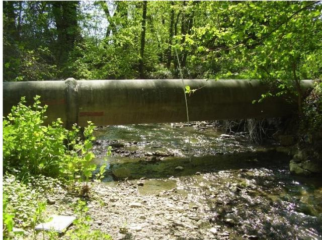
Photo de la traversée du DN600. Sous l'ouvrage, il n'y a que 65cm disponibles.
