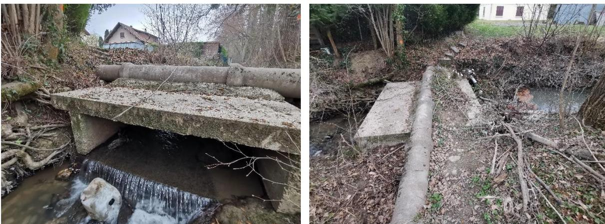
Photo de la traversée du DN300 collectant les eaux usées du chemin du Nant. On note la faible profondeur du ruisseau du Nant à cet endroit ainsi que la présence d'embâcles constituée de branches, de feuilles et de débris à son amont.
