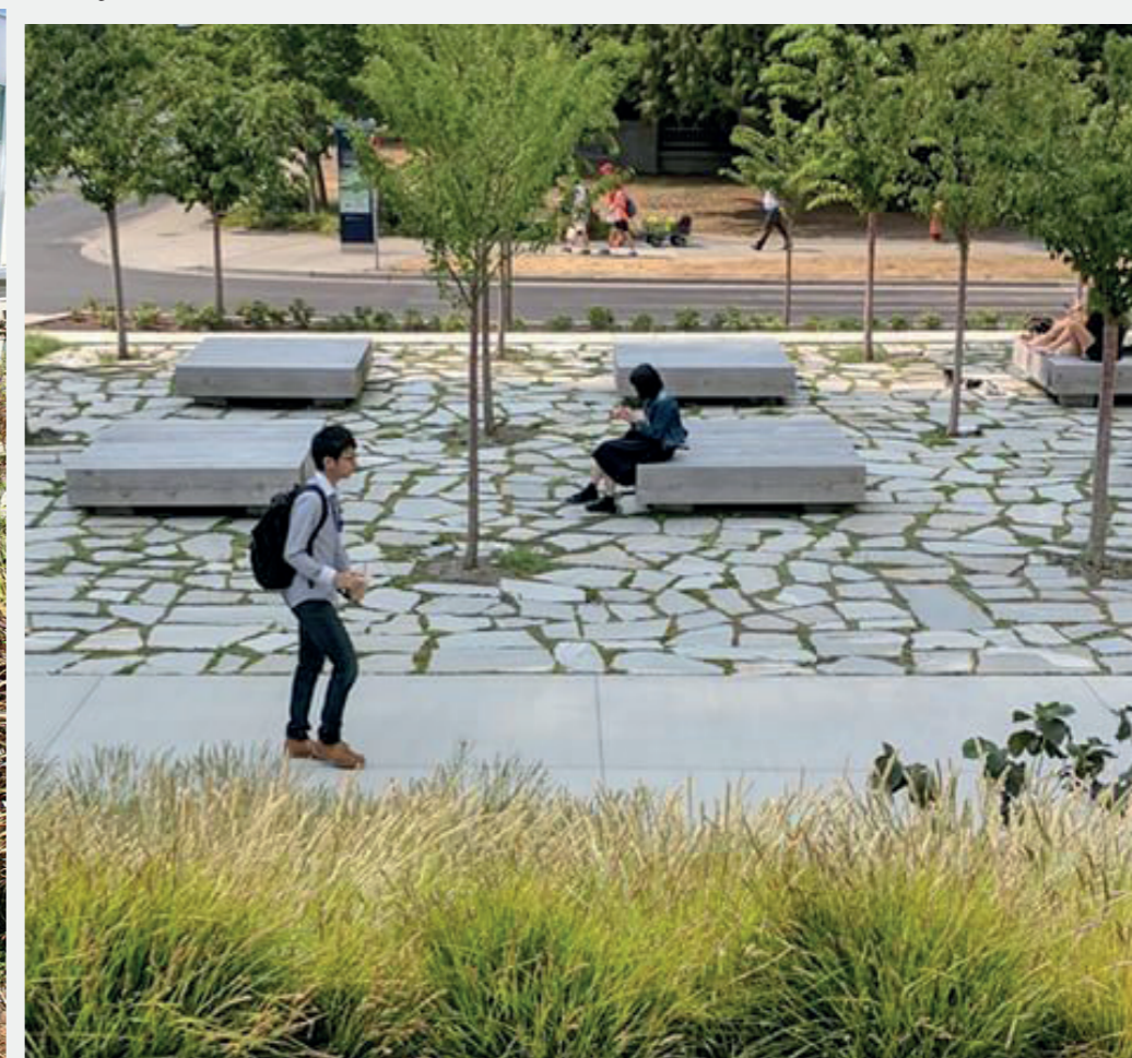
Opus incertum en pierre naturelle (gneiss/granit) et joints enherbés
