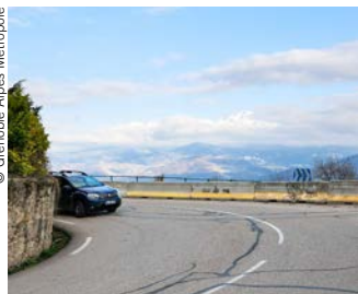
Les travaux vont impliquer la fermeture de la route.
