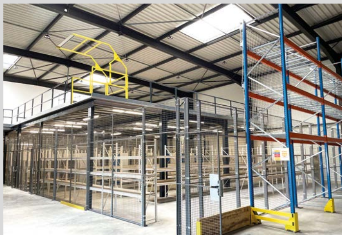
Plateforme de stockage, rayonnages et cloisons grillagées
