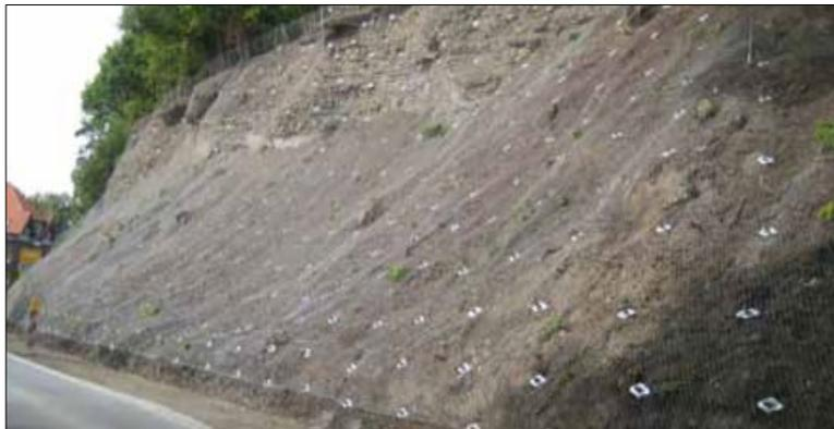
Figure 16 : Exemple de confortement de terrain meuble - Tecco®
