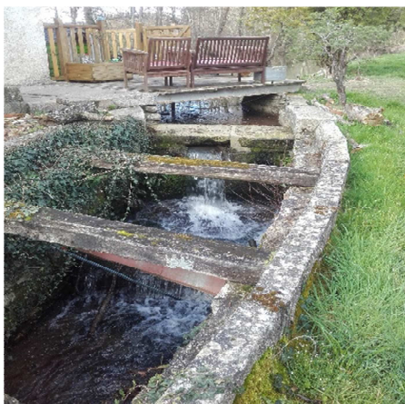
Vue aval de l'ouvrage
