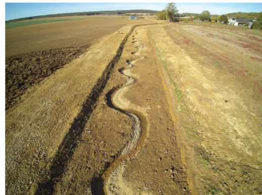
Illustration de retalutage de berge pour constitution de lits emboîtés
