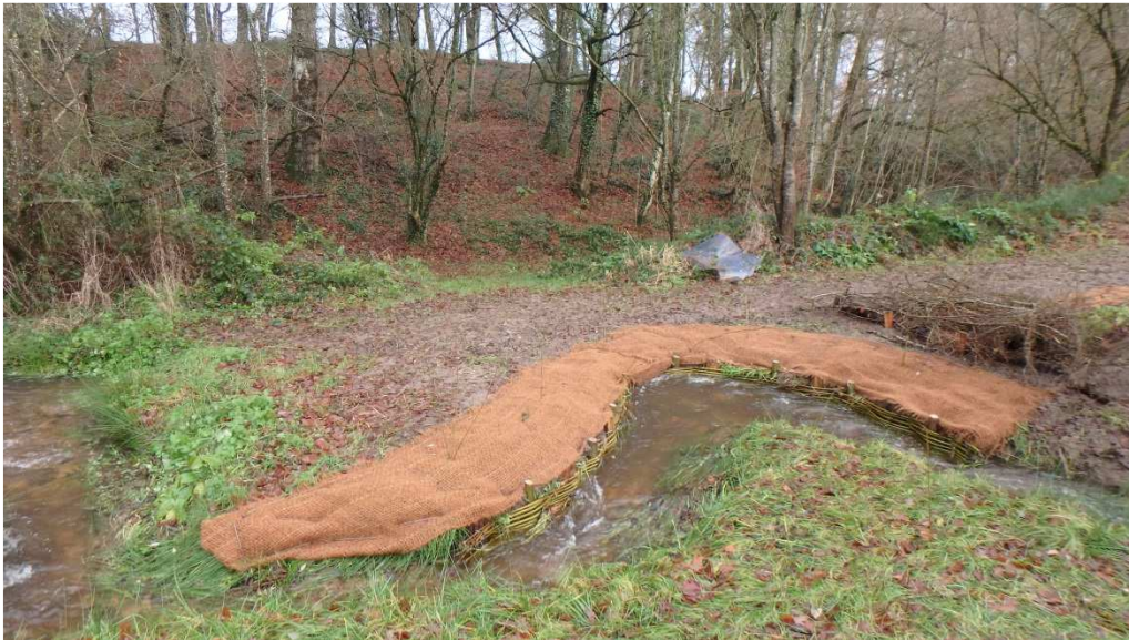
Illustration de tressage de saule sur la Pourcellière (61) – Photo : PNRNM
