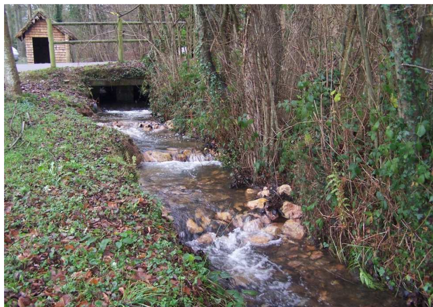
Aperçu de pré-barrage sur le ruisseau de Rouperroux à Rouperroux (61) – Photo : PNRNM
