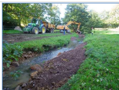
Illustration de recharge en granulats par banquettes sur la Maure à la Ferté-Macé (61) – Photos : PNRNM
