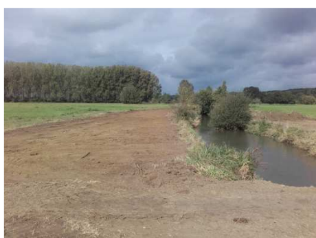
Figure 13 : Exemple d'arasement d'un merlon de curage le long de la Sarthe.
