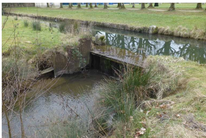
Vue aval de l'ouvrage
