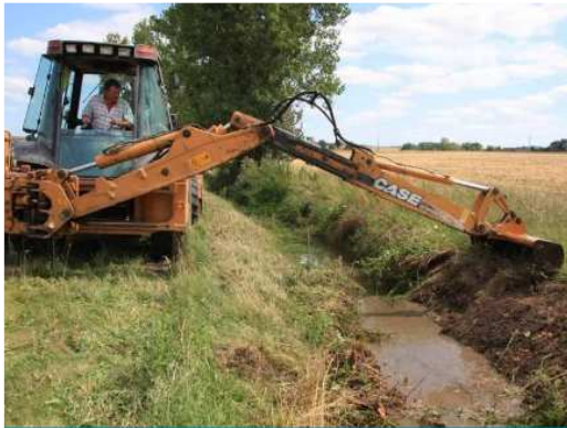
Illustration de retalutage de berge pour constitution de lits emboîtés
