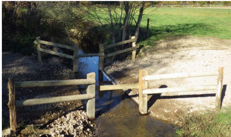
Illustration de passage à gué sur la ve aux monts d'Andaine - Photo : PNRNM
