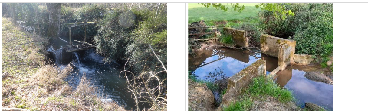
Exemples d'ouvrages à effacer : vannage sur le Gesnes à Arçonnay et ancien système de prise d'eau sur le Sarthon à Villeneuve en Perseigne
