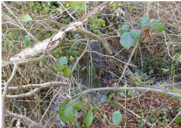
Vue aval de l'ouvrage
