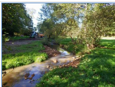
Illustration de recharge en granulats par banquettes sur la Maure à la Ferté-Macé (61) – Photos : PNRNM
